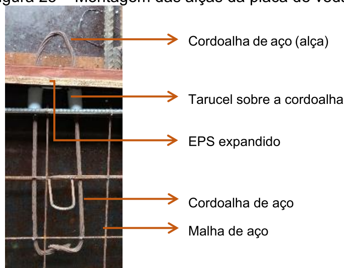
Figura 25 – Montagem das alças da placa de vedação
