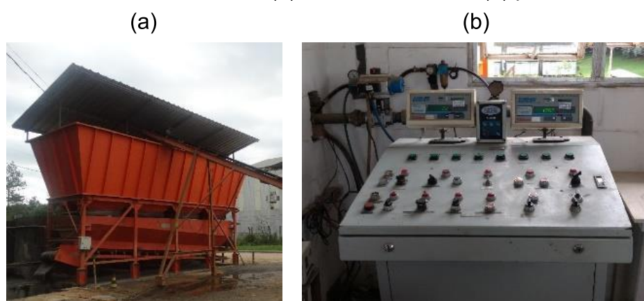
Figura 26 – Central dosadora: (a) silos individuais e (b) painel de controle
