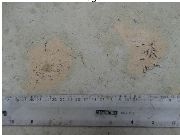
Figura 70 – Detalhe da superfície exposta FIB0,5% após ensaio de resistência ao fogo
