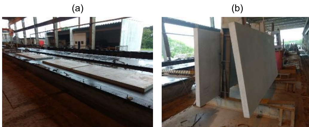
Figura 31 – Placas de vedação (a) com as formas laterais removidas (b) armazenadas dentro da fábrica
