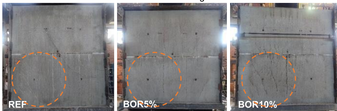
Figura 65 – Superfície não exposta: REF, BOR5% e BOR10% após ensaio de resistência ao fogo
