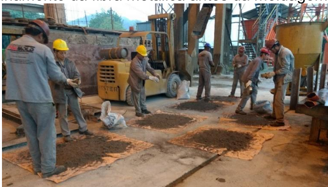
Figura 28 – Polvilhamento da fibra metálica antes da moldagem do traço FIB1,5%
