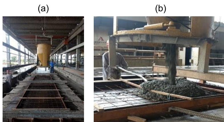
Figura 30 – Concreto fresco: (a) transporte e (b) lançamento
