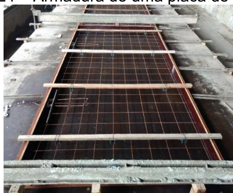
Figura 24 – Armadura de uma placa de vedação
