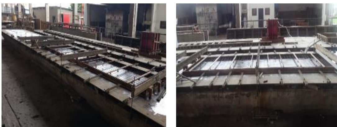
Figura 22 – Formas de madeira das placas de vedação: (a) vista lateral e (b) frontal
