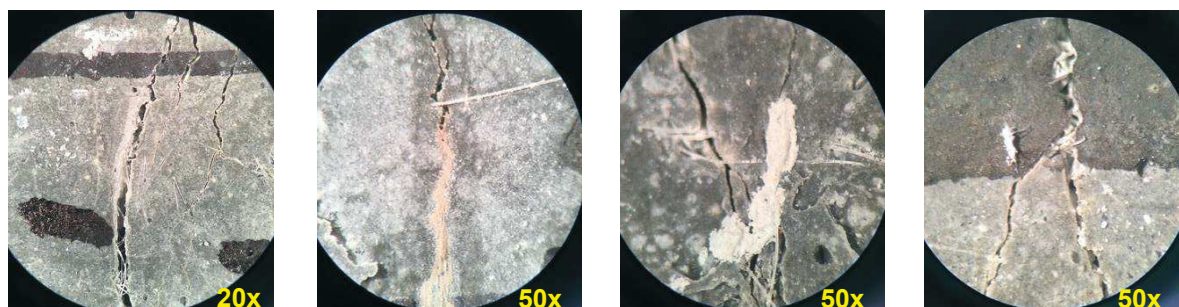
Figura 148 – Aspecto do produto formado pelas soluções bacterianas nas fissuras dos compósitos
