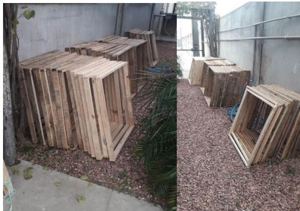
Figura 10: Confeção de fôrmas em madeira para as três espessuras utilizadas
