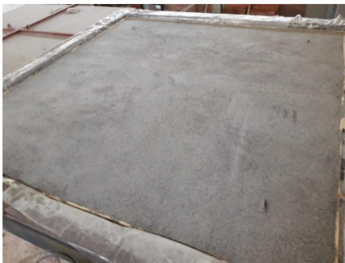
Figura 111: Aplicação do traço 4 com 100% de substituição na laje inteira na câmara acústica, com espessura de 5 cm.
