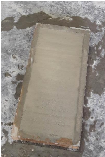
d) Argamassa após sarrafeamento;
