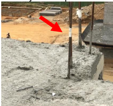
Fotografia 1 - Nível marcado nas barras de aço de espera.
