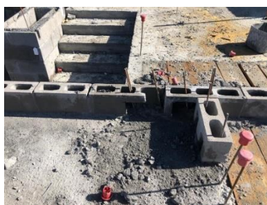
Fotografia 5 - e janelas de inspeção do graute.
