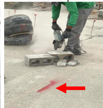
Fotografia 3 - Marcação das linhas limitantes da parede
