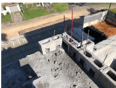
Fotografia 4 - Assentamento de “blocos-chaves” nos encontros entre paredes
