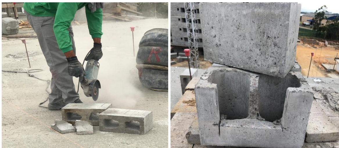
Fotografia 8 - Corte das janelas de inspeção nos blocos
