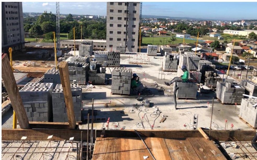
Fotografia 7- Distribuição dos paletes de blocos na laje de trabalho
