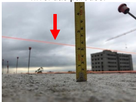
Fotografia 2 - Alinhamento e nível das paredes.
