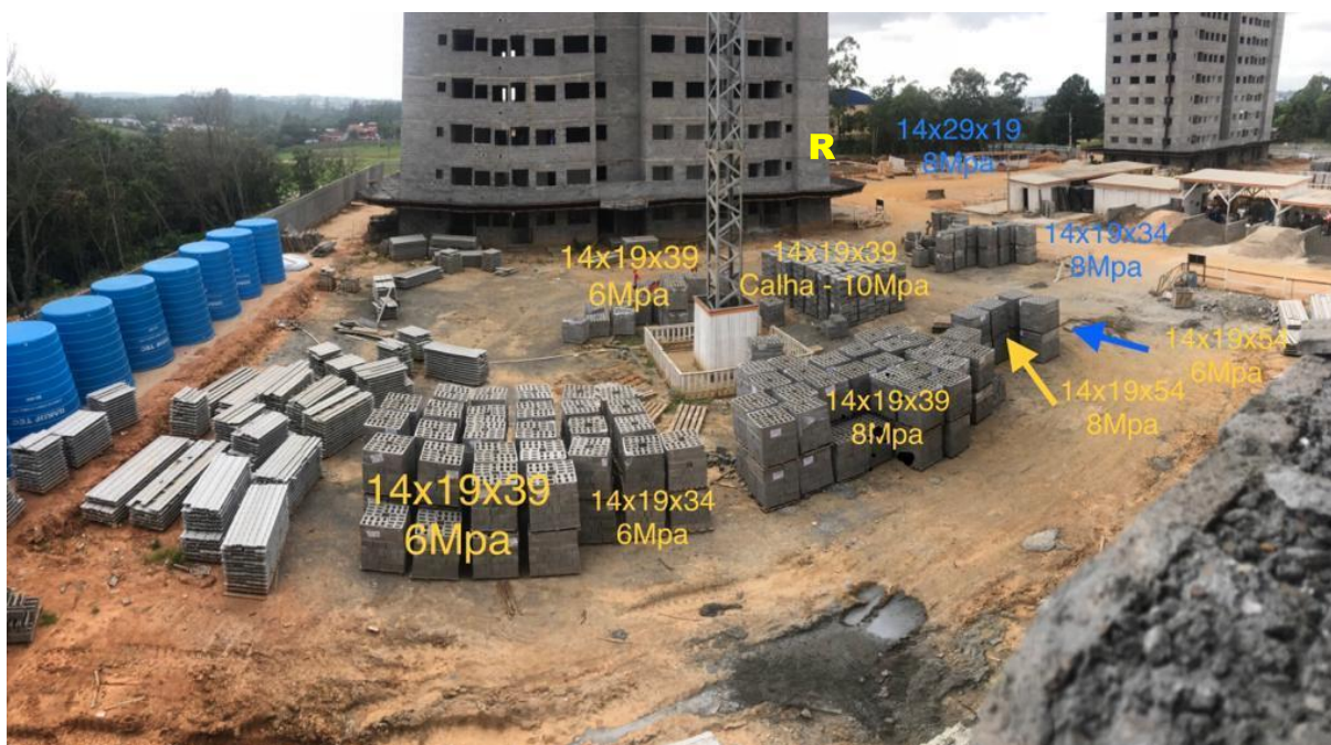
Fotografia 6 - Estoque de paletes de blocos de concreto
