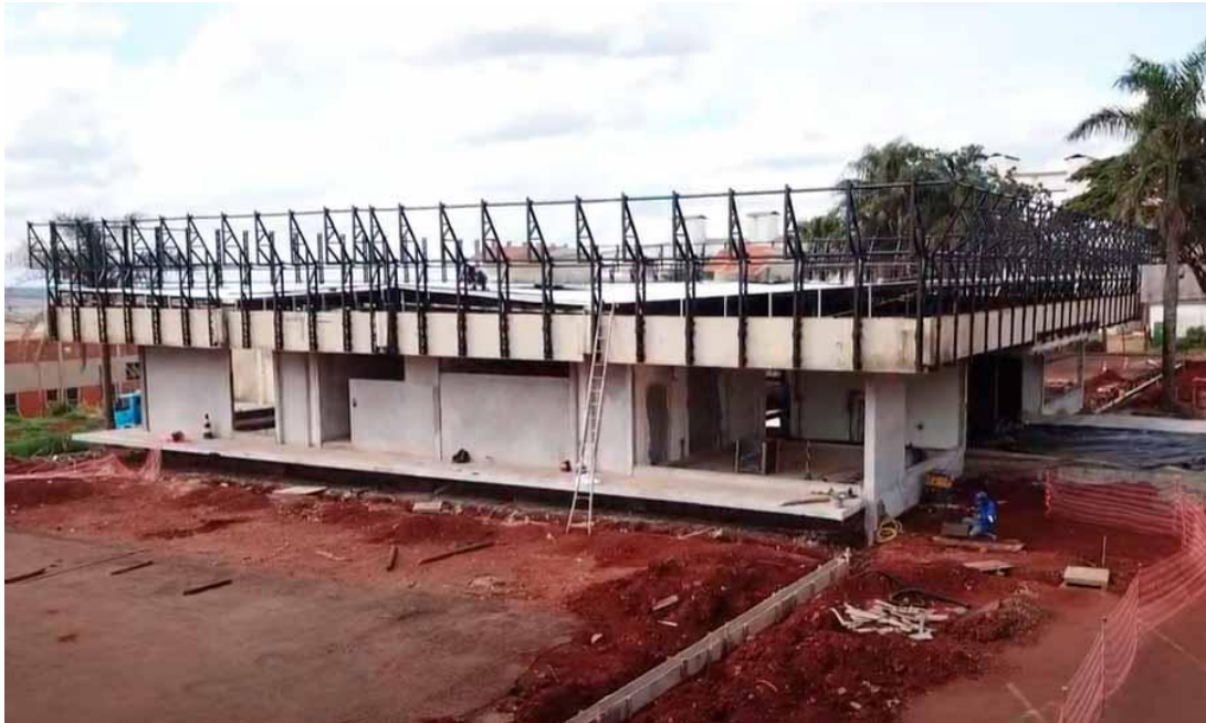
Figura 12 - Obras em Andamento do Novo TECA
