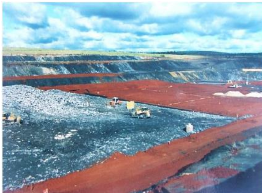
Figura 5 – Aterro sanitário na fase inicial em Minas do Leão/RS
