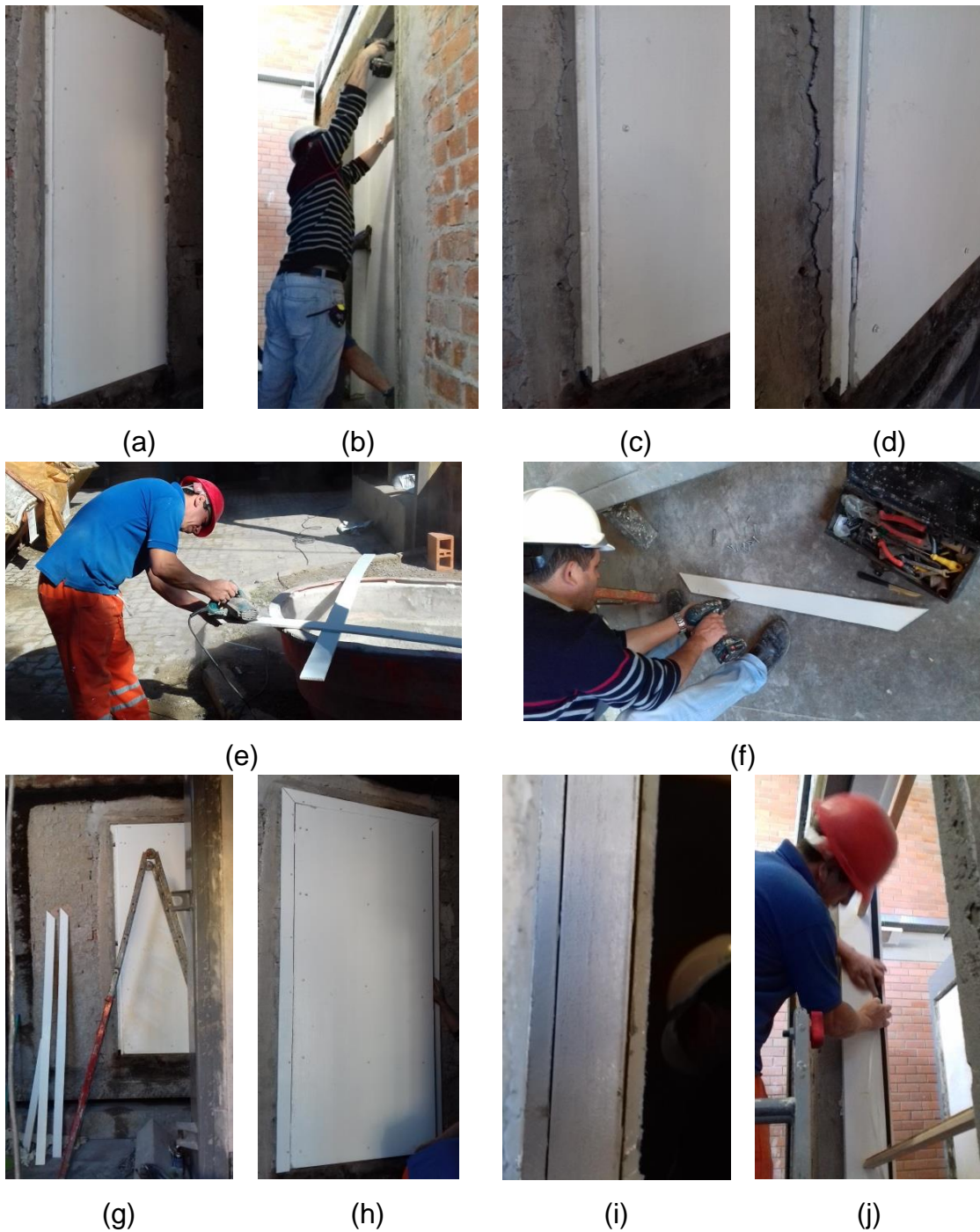
Figura 21 - Montagem porta P4
