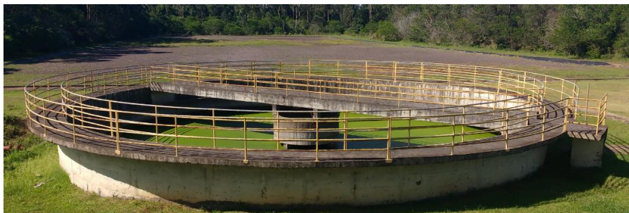
Fotografia 6 - Decantador Circular
