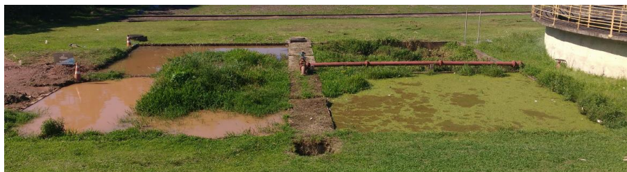
Fotografia 7 - Leitos de Secagem
