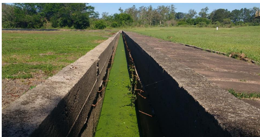
Fotografia 9 - Calha de Entrada
