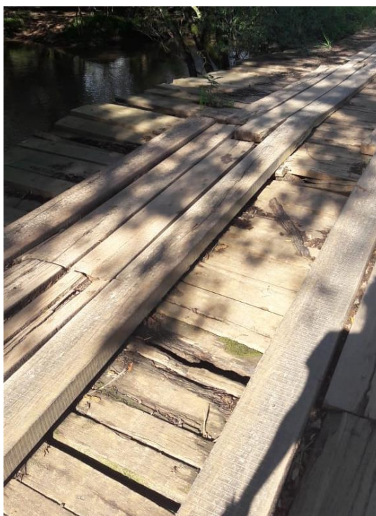
Fotografia 2 – Condições da superestrutura da Ponte nº 23
