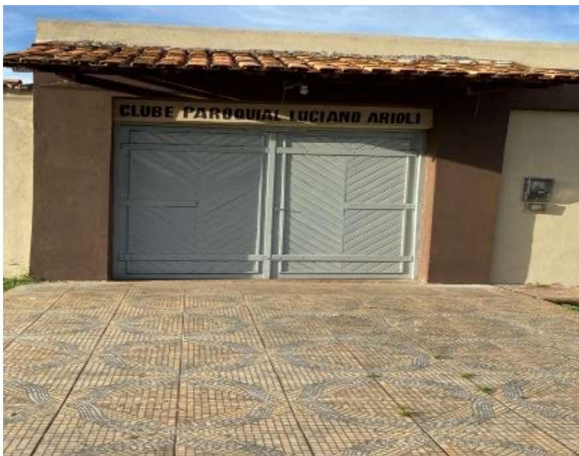
Fotografia 14: Vista do portão de entrada do Clube Paroquial Luciano Arioli
