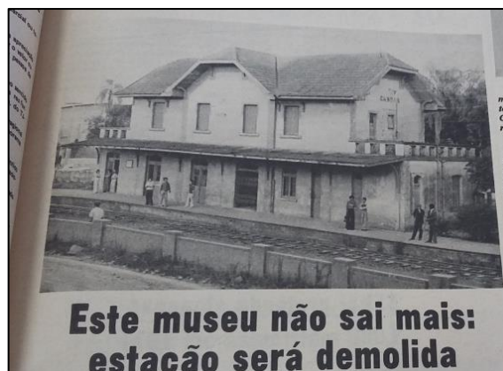
Figura 14 – Estação será demolida
