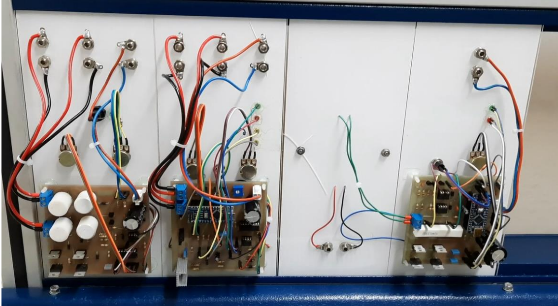
Figura 84: Vista traseira dos dispositivos em bancada (placa do retificador controlado à esquerda, softstarter ao centro e inversor de frequência à direita)
