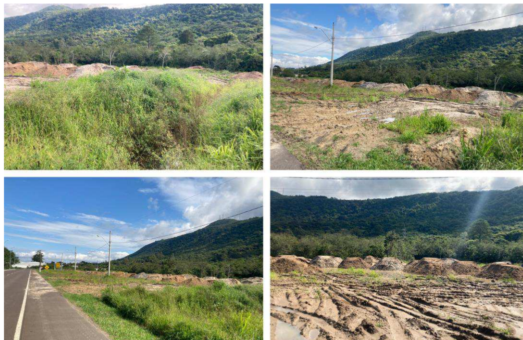
Figura 36 – Desflorestamento e movimentação de terra no sopé do Morro de Osório.
