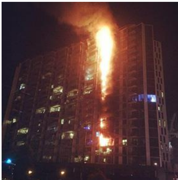
Figura 19 - Incêndio no prédio Lacrosse
