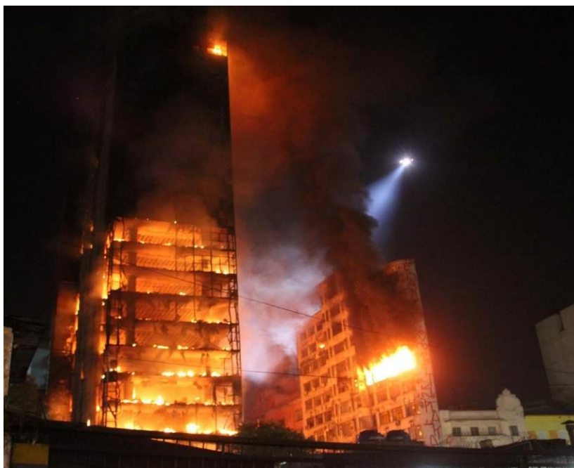
Figura 10 – Exemplo da falta de compartimentação no edifício Wilton Paes de Almeida no Largo do Paiçandu, São Paulo.
