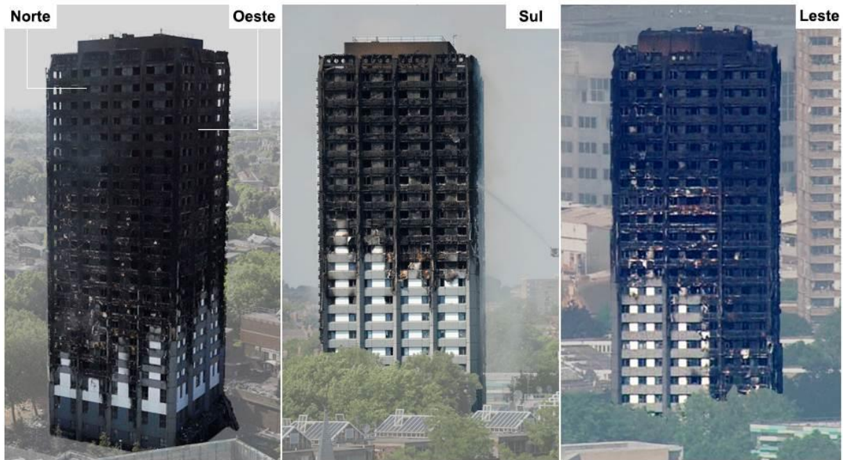
Figura 2 – Incêndio na Greenfell Tower
