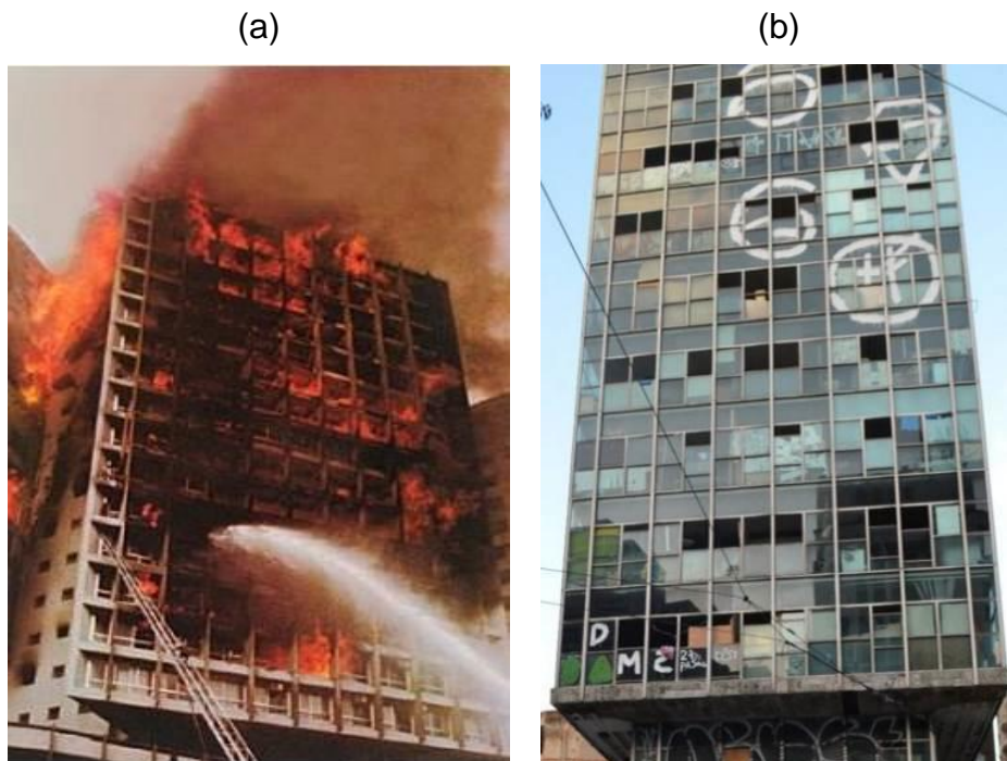
Figura 1 – Incêndio no (a) edifício Joelma; (b) Fachada de pele de vidro do edifício Wilton Paes de Almeida
