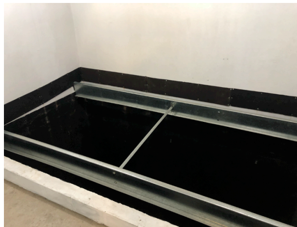
Figura 56 – Estrutura metálica no vão da câmara
