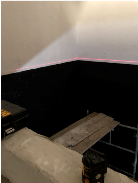
Figura 50 - Nivelamento para o suporte 1
