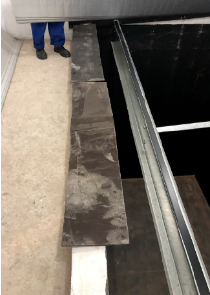
Figura 65 – Instalação do EVA na face da calha
