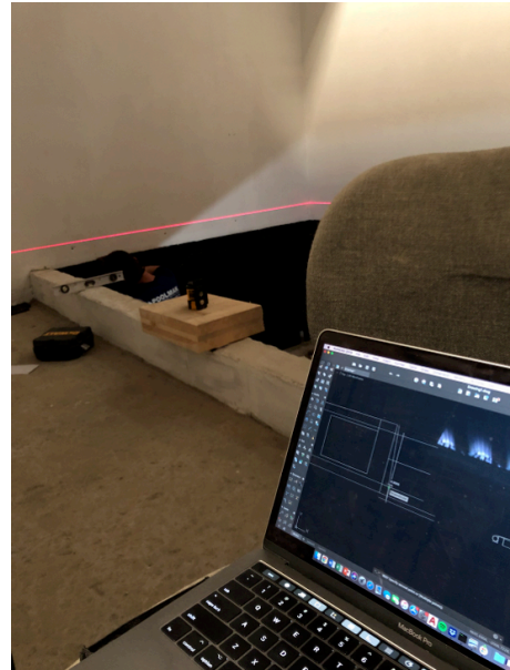
Figura 51 - Instalação do suporte
