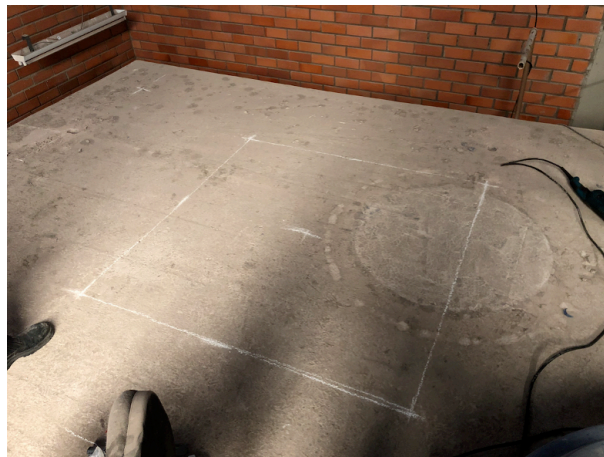
Figura 41 – Marcação de corte na laje superior
