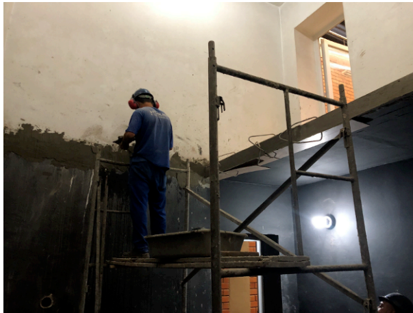
Figura 48 – Reboco dos pontos rompidos e aberturas existentes
