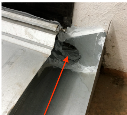
Figura 63 – Interface da calha metálica com a alvenaria
