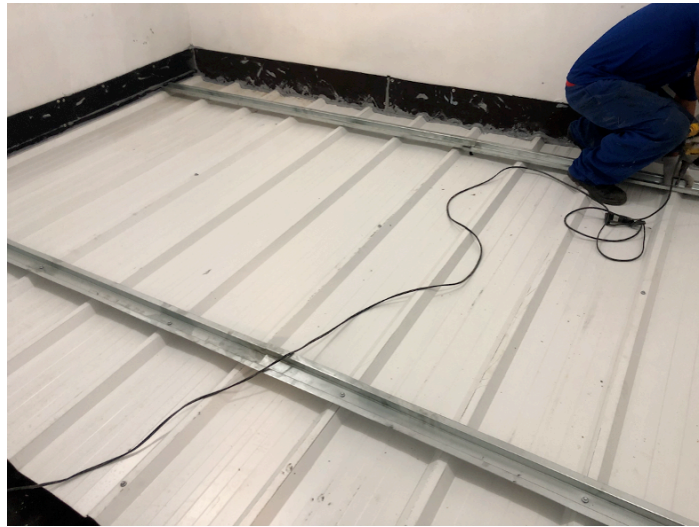
Figura 75 – Instalação dos perfis cartola
