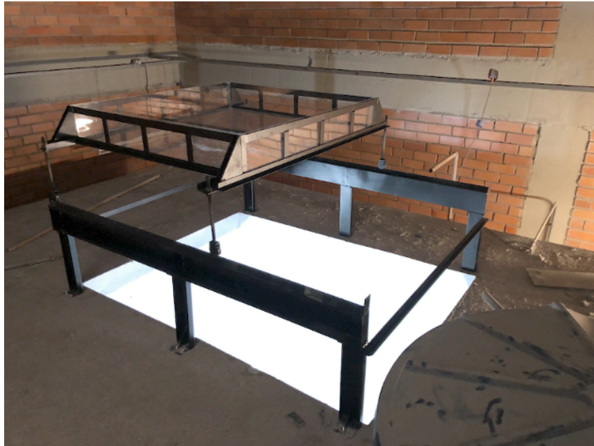
Figura 59 – Estrutura de sustentação
