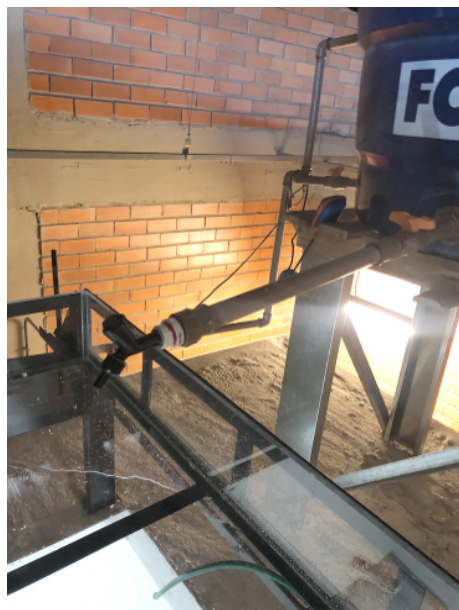
Figura 60 – Estrutura de sustentação
