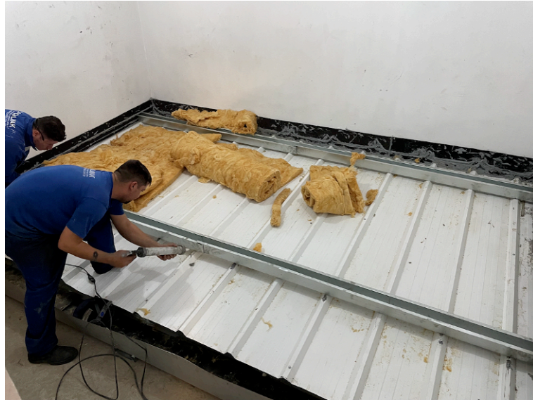
Figura 82 – Instalação dos cartolas na amostra 09
