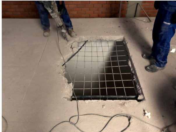
Figura 43 – Abertura da laje superior
