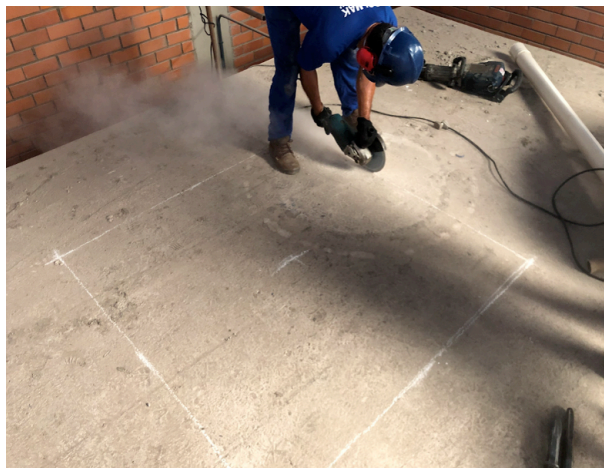
Figura 42 – Corte laje superior
