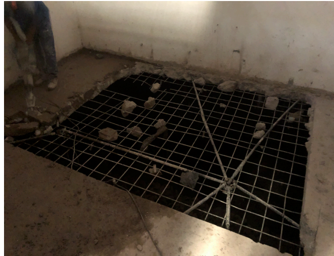
Figura 46 – Abertura da laje inferior
