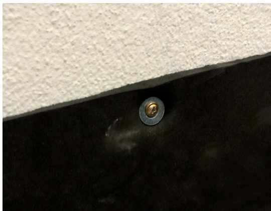
Figura 54 – Fixação do EVA na alvenaria
