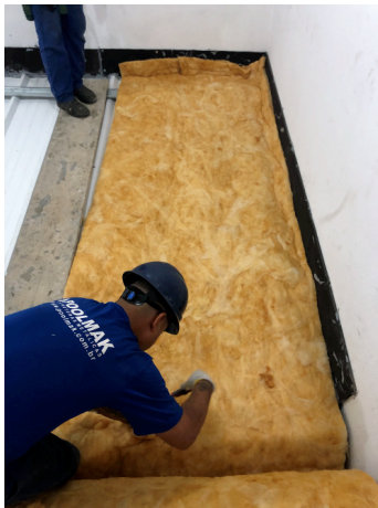
Figura 77 – Instalação da lã de vidro 50 mm
