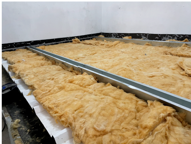
Figura 83 – Instalação da lâã de vidro na amostra 09
