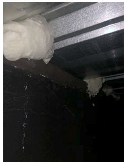
Figura 70 – Aplicação espuma expansiva
