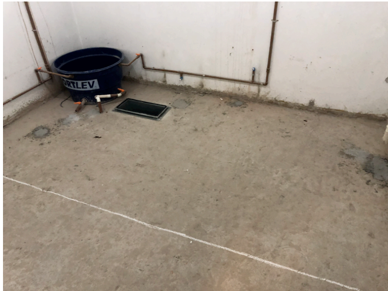
Figura 45 – Marcação laje inferior
