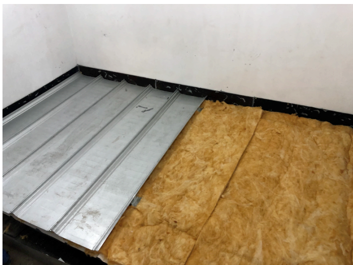
Figura 79 – Instalação da telha zipada - Cobertura
