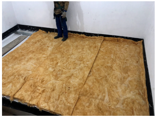
Figura 78 – Lã de vidro sobre os perfis
