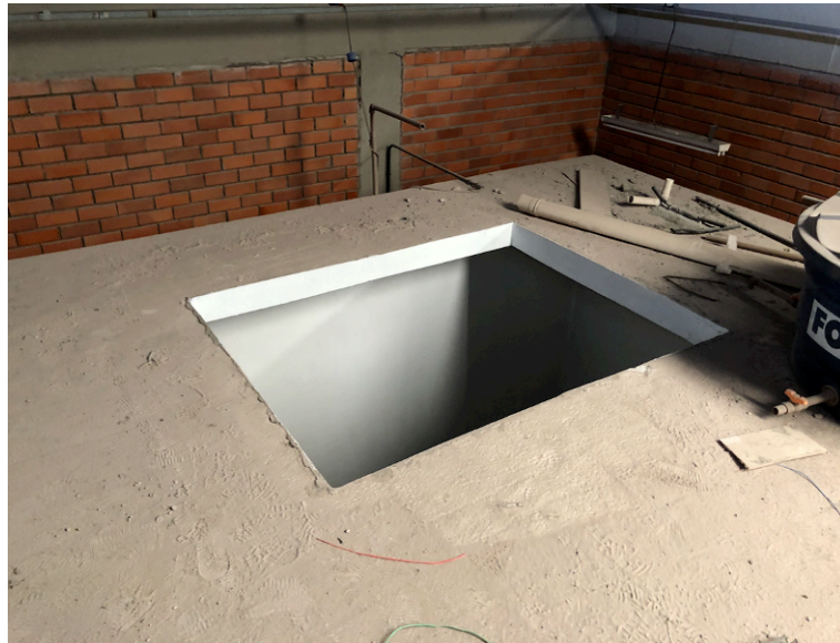
Figura 44 – Abertura da laje superior finalizada
