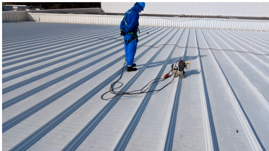
Figura 27 – Sistema de cobertura com processo de zipagem
