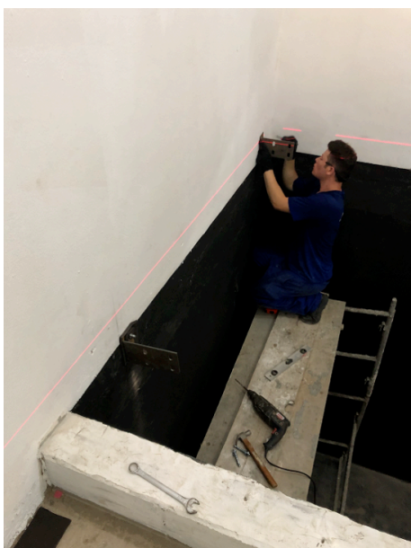
Figura 52 – Instalação do suporte 2
