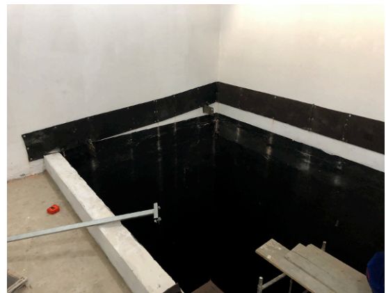
Figura 55 – Instalação do EVA no perímetro do vão
