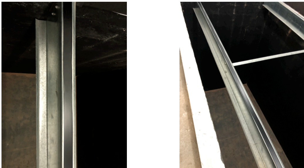
Figura 57 – Fita de isolamento
