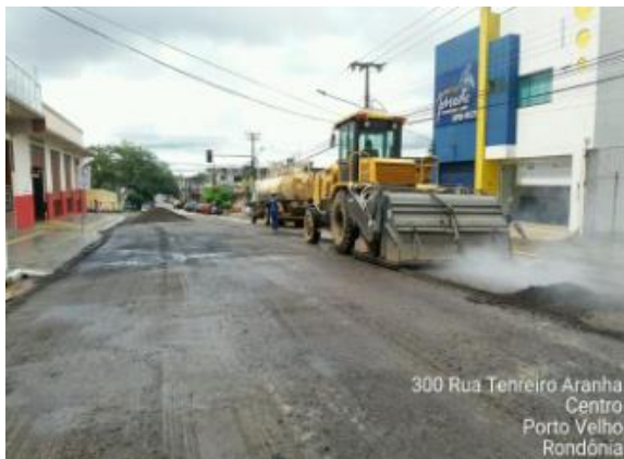
Figura 9 – Serviço de fresagem na Rua Tenreiro Aranha: a) processo de fresagem; e b) retirada do material fresado
