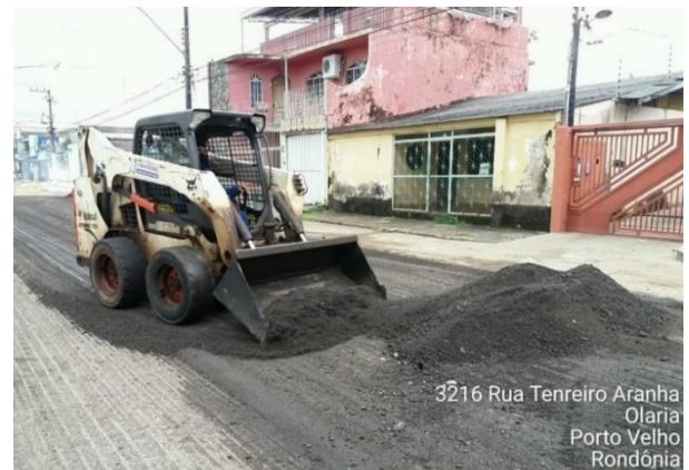
Figura 9 – Serviço de fresagem na Rua Tenreiro Aranha: a) processo de fresagem; e b) retirada do material fresado
