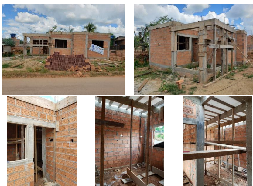
Figura 15 – Fotos da UH91 com obra em andamento
