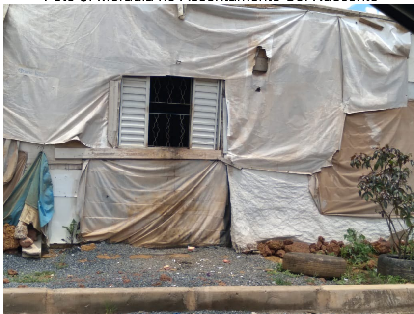
Foto 9. Moradia no Assentamento Sol Nascente
