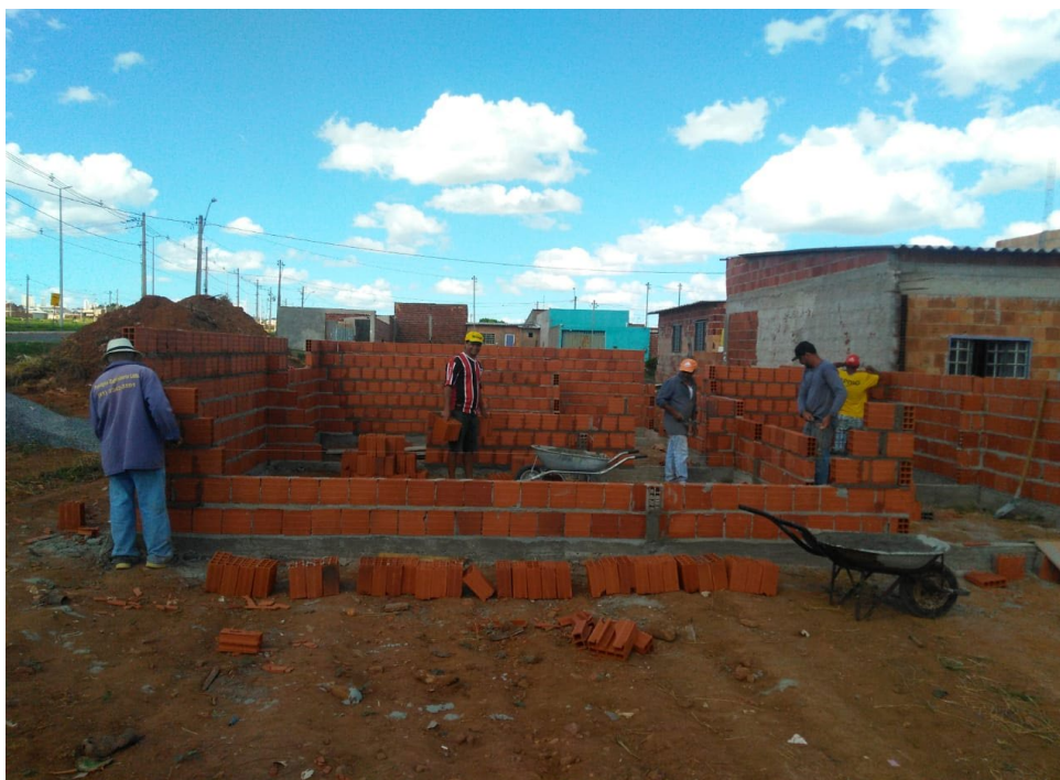
Foto 5. Construção da Cozinha Solidária Assentamento Sol Nascente
