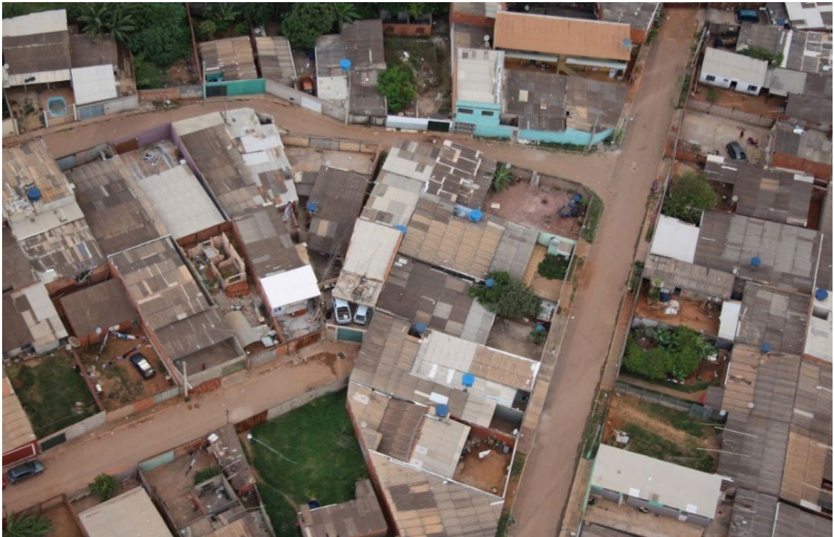
Foto 8. Vista aérea Assentamento Sol Nascente
