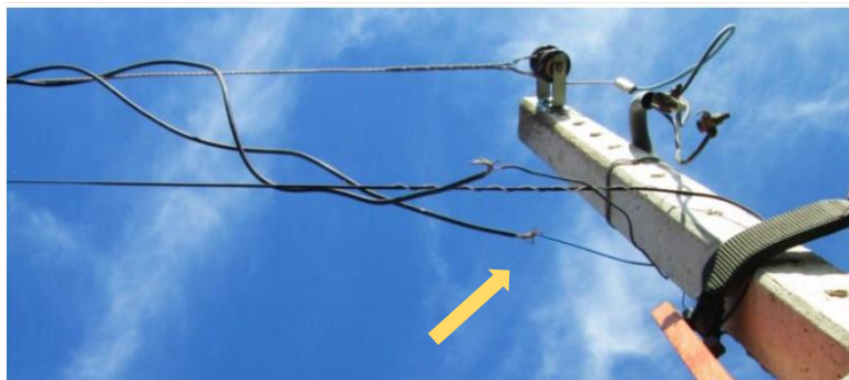
Figura 3 - Furto por ligação clandestina no ramal de ligação
