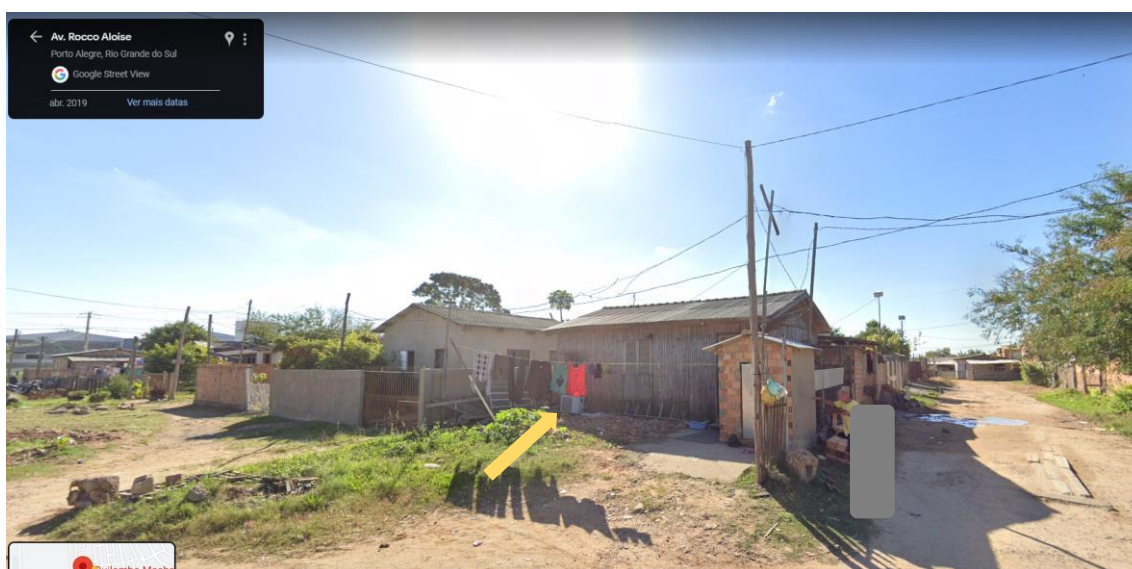
Figura 23 - Rede de distribuição improvisada Avenida Rocco Aloise
