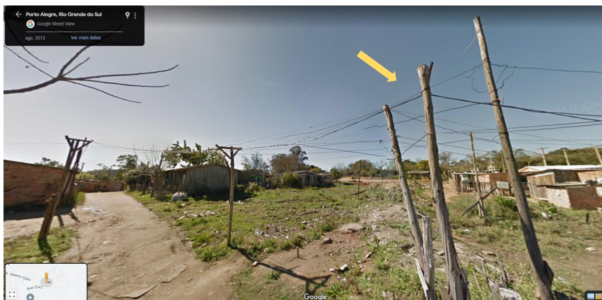
Figura 34 - Rede de distribuição irregular Rua Um
