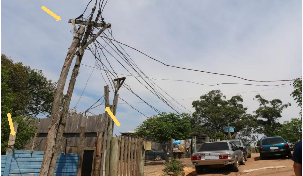
Figura 15 - Rede de distribuição na Rua Ventura Pinto
