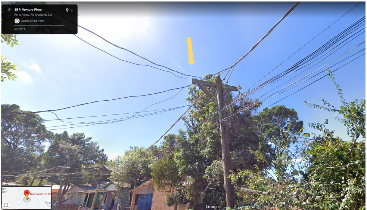
Figura 16 - Rede de distribuição na Rua Ventura Pinto
