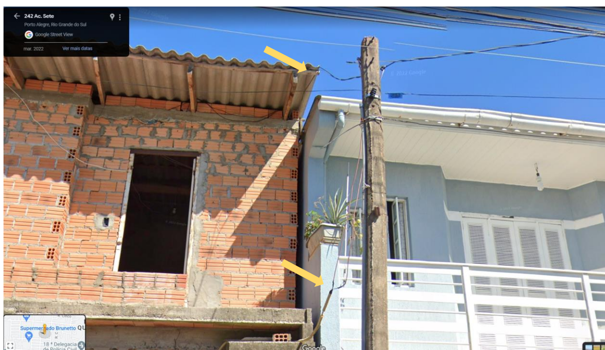
Figura 31 - Rede de distribuição com ligações irregulares Acesso Oito (ampliada)
