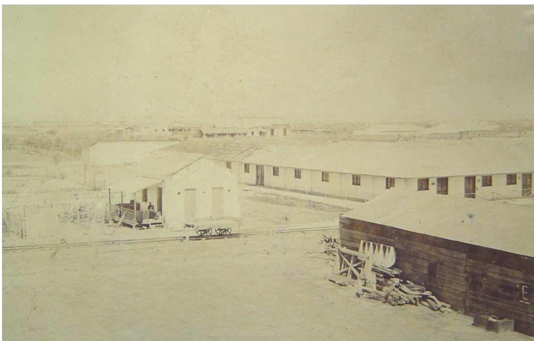
Foto 09 - Vista do início da construção do balneário.
