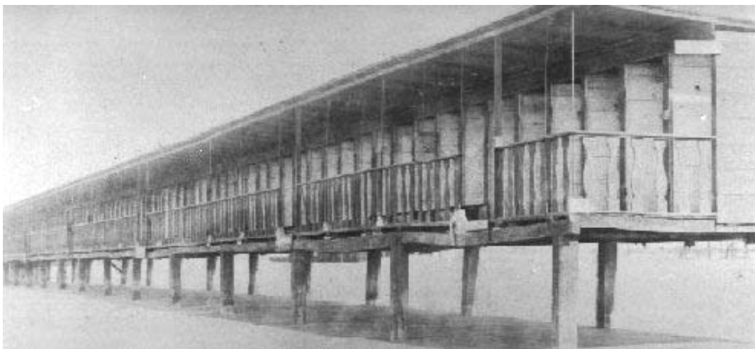
Foto 12 - Camarotes ainda em construção.
