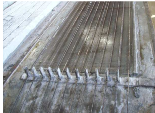
Figura 26: armadura da laje
