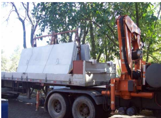
Figura 60: Painéis posicionados em forma de "V" no caminhão
