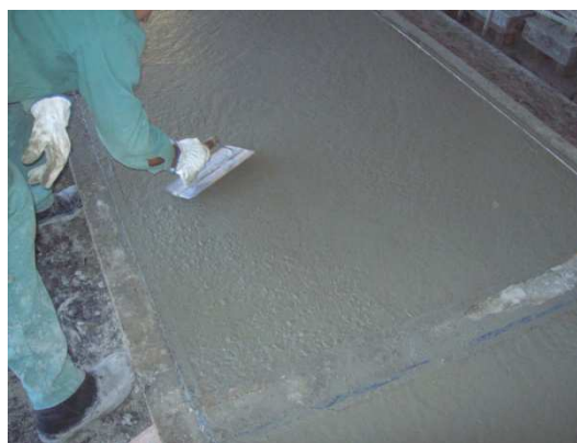
Figura 56: Queima dos painéis pré-fabricados
