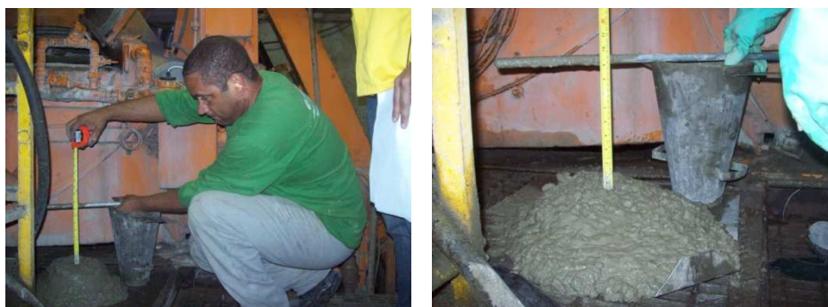
a) Abatimento concreto de referência
