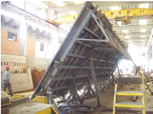
Figura 28: desmoldagem e tombamento das peças
