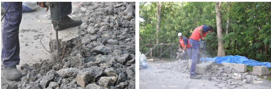
Figura 46 Cominuição primária das estacas (RCT)
