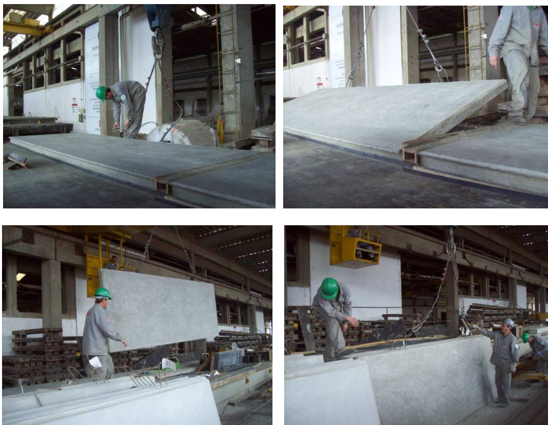
Figura 57: Processo de desmoldagem dos painéis.
