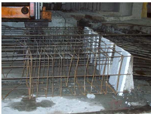
Figura 43: Cabeças das estacas com isopor
