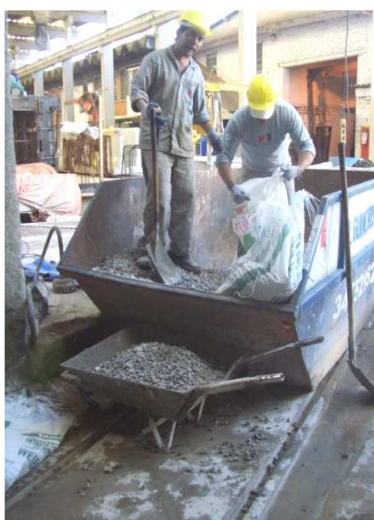
Figura 51 Retirada do ARCT da caçamba
