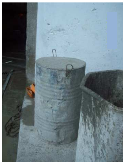
Figura 35: Resíduo de concreto fresco em tonel
