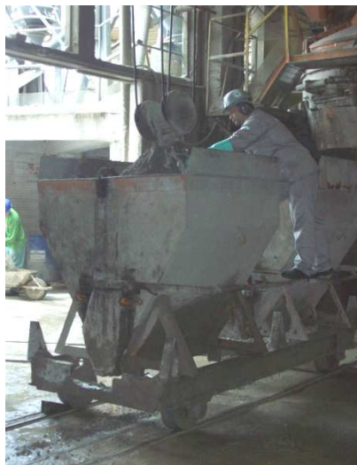
Figura 21: Início transporte de concreto
