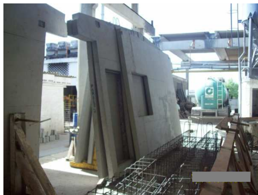
Figura 33: Armazenamento de peça (painéis)
