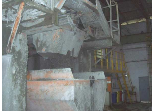
Figura 20: Descarregamento do concreto na caçamba
