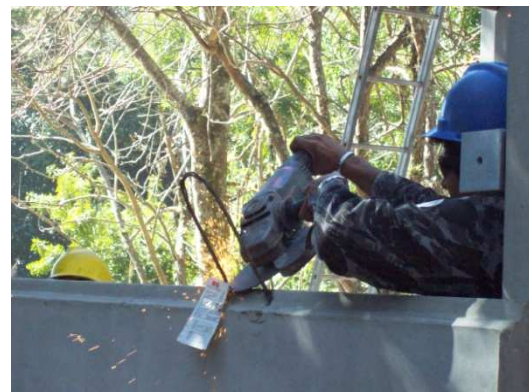
Figura 63: Retirada das alças de aço
