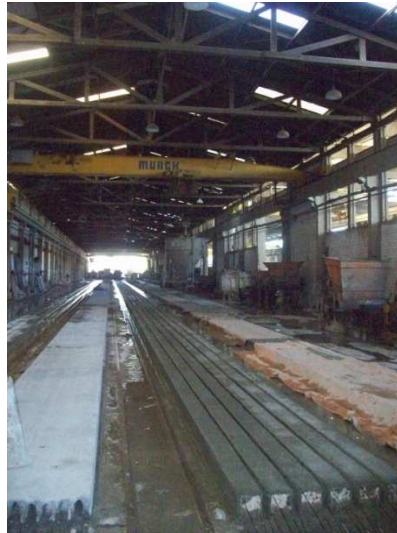
Figura 9: Fábrica 1- vista Sul (pista de produção de estacas e lajes)
