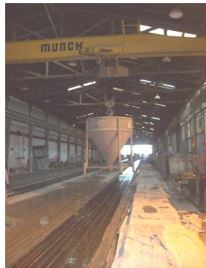
Figura 22: Transporte do concreto através de ponte rolante
