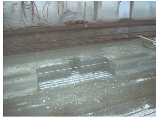
Figura 31: corte da laje
