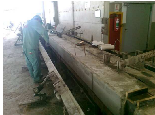
Figura 29: desmoldagem de pilar (forma metálica)
