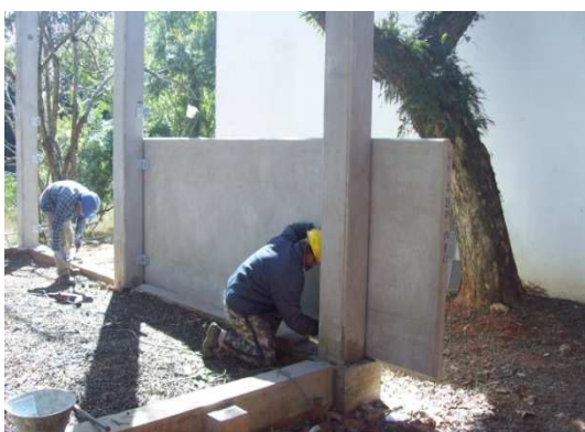
Figura 62: Posicionamento da primeira linha de painéis (CRef.)
