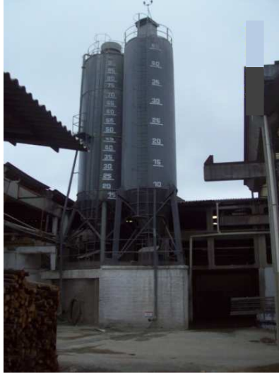
Figura 13: Silos de cimento e cinza
