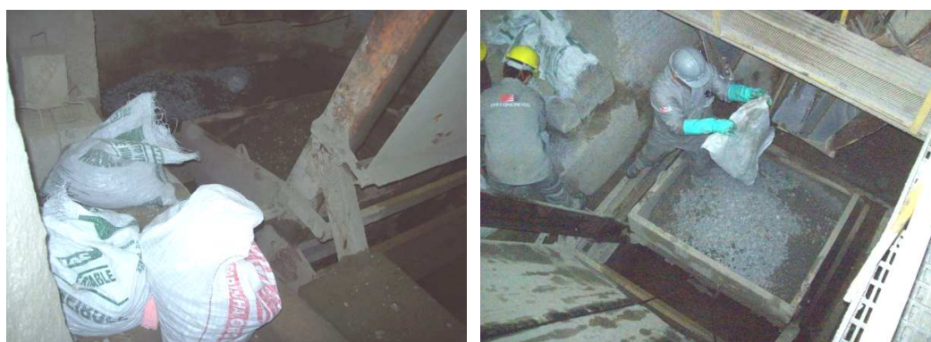
Figura 52 Abastecimento da caçamba com ARCC
