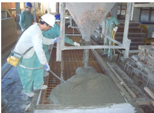
Figura 55: Moldagem dos painéis pré-fabricados.
