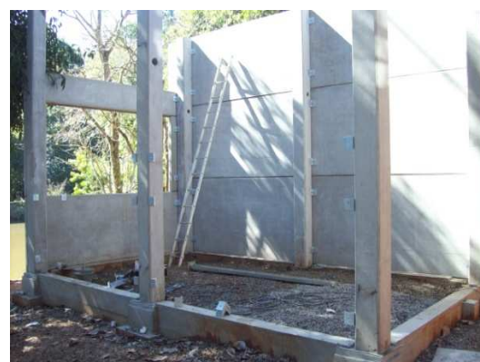
Figura 65: Finalização das fachadas Leste e Norte
