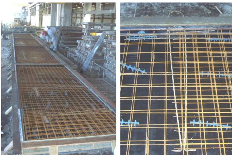
Figura 54: Amadura utilizada para produção de todos os painéis pré-fabricados.
