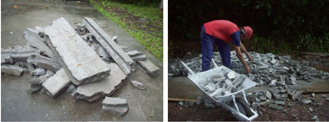
Figura 47 Cominuição primária das lajes (RCC)
