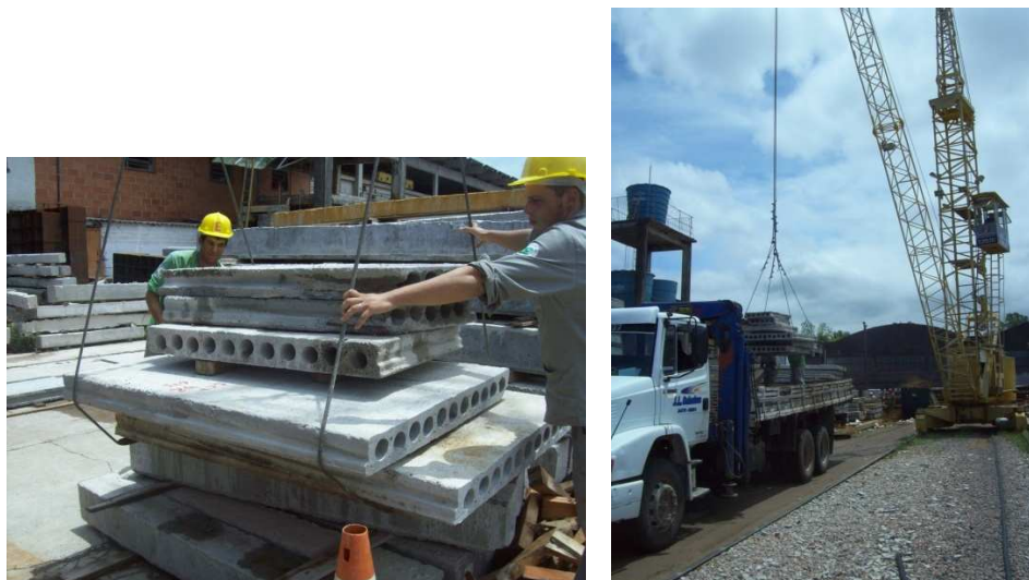
Figura 45: Coleta do RCC (lajes alveolares) no pátio da empresa
