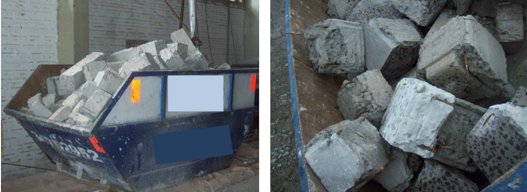
Figura 44: Resíduos do RCT (estacas)
