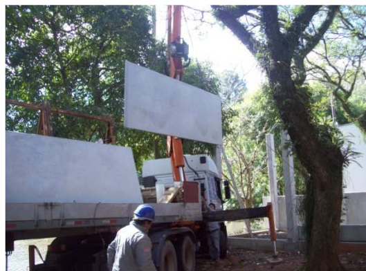
Figura 61: Içamento da peça
