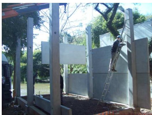
Figura 64: Posicionamento da segunda linha de painéis (CRCT)
