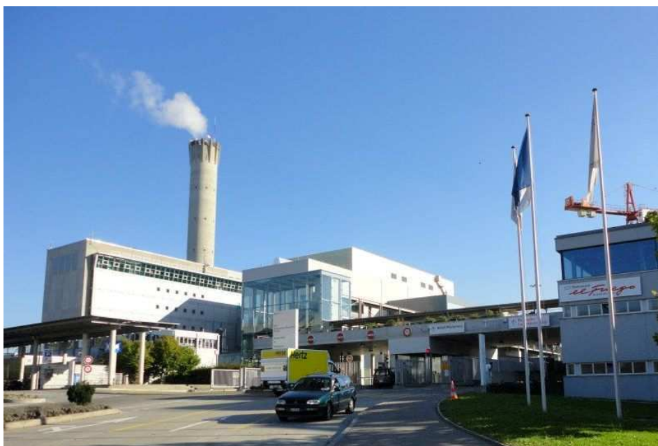
Figura 34 – Sede administrativa do ERZ e usina de incineração Hagenholz.
