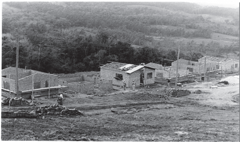
Figura 29 - Construção das 11 unidades habitacionais do Bairro Vila Becker (1995) Fonte: Prefeitura de Dois Irmãos (2011).
