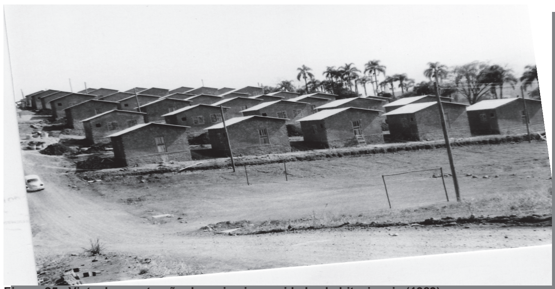
Figura 25 - Vista da construção das primeiras unidades habitacionais (1989) Fonte: Prefeitura de Dois irmãos (2011).
