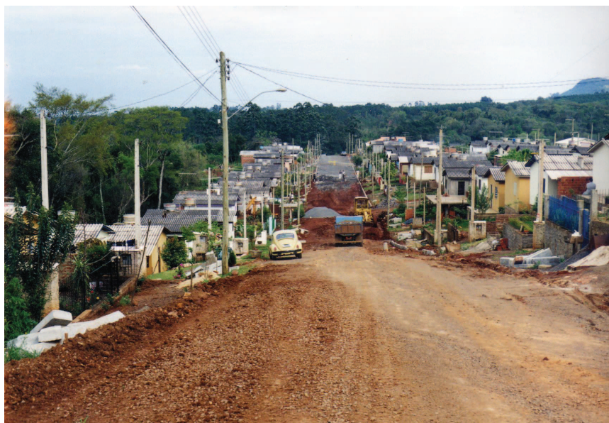
Figura 31 - Execução concluída da segunda parte do loteamento 48 com setenta casas (1998) e recebimento de melhorias com a pavimentação das ruas
