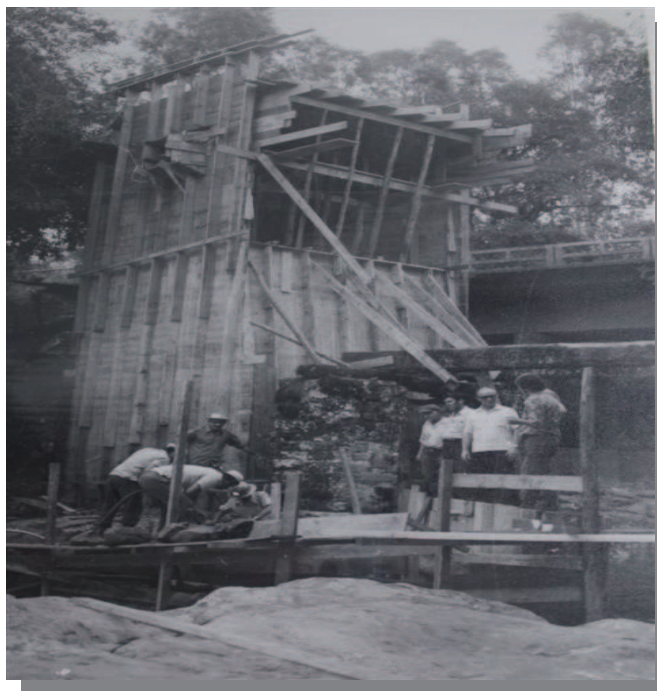
Figura 13 - Vista da construção do ponto de captação para água tratada Foto: Museu Dois Irmãos (2011).
