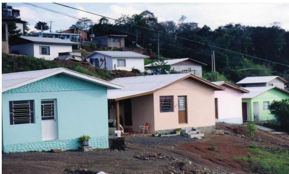
Figura 34 - Execução de unidades habitacionais na Estrada Campo Bom, Bairro São João (2002)
