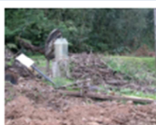
2013 – início do processo de asfalto
