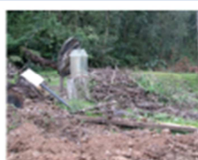
2013 – início do processo de asfalto
