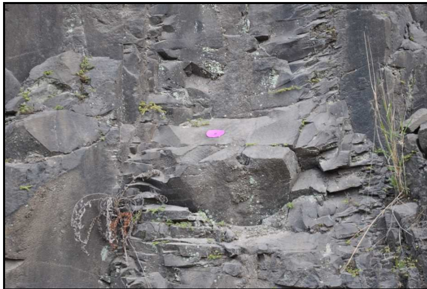
Figura 21 - Plano 6 na fotografia identificando a irregularidade da superfície.
