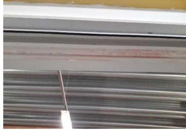
Figura 4.39 Rastros da passagem de ar região superior esquadria integrada
