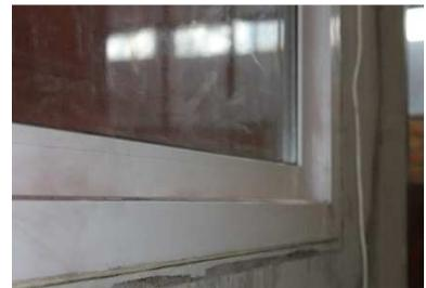
Figura 4.37 Infiltração de ar aresta inferior esquadria integrada.
