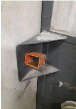
Figura 3.24 Montagem dos tirantes roscados, fixação da câmara I.
