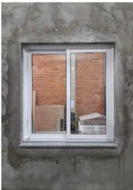
Figura 3.17 Fixação da esquadria na parede de alvenaria.
