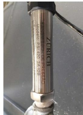
Figura 3.22 Acoplamento do transmissor de pressão.
