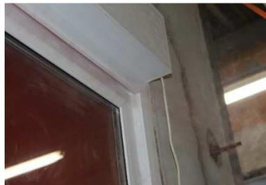
Figura 4.36 Infiltração de região superior esquadria integrada.
