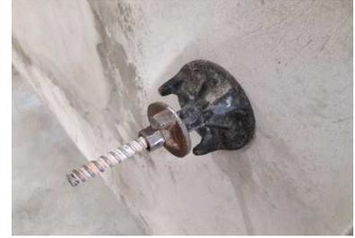
Figura 3.25 Montagem dos tirantes roscados, fixação da câmara II.
