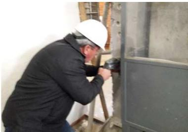
Figura 3.20 Furação da parede para inserção dos tirantes roscados.
