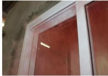
Figura 4.13 Infiltração de ar região superior esquadria de correr II.
