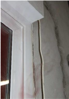
Figura 4.38 Infiltração de ar aresta lateral esquadria integrada.
