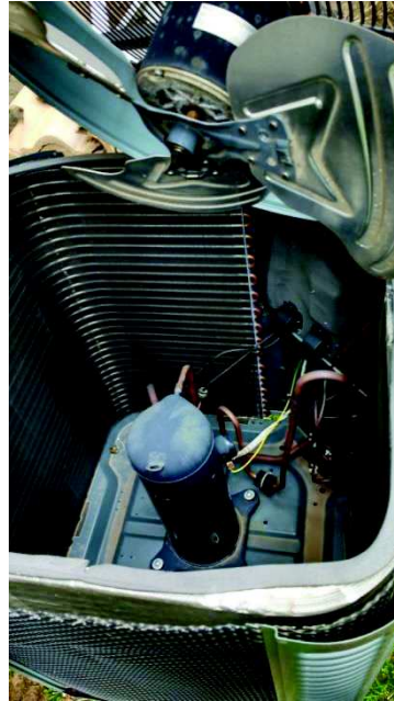
Figura 3 – Condensadora aberta com compressor
