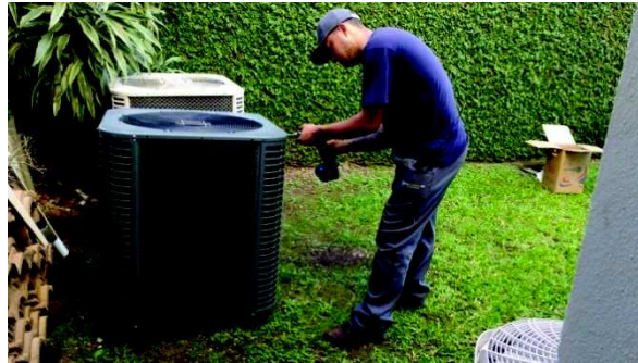
Figura 5 – Desmontagem / Remontagem do sistema ventilação
