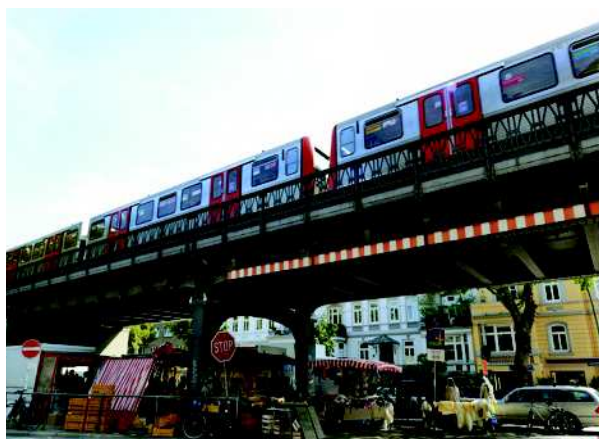
Figuras 45: vista do funcionamento atual do mercado
