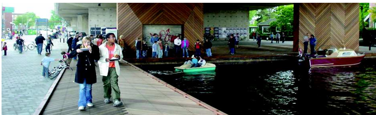
Figura 57: mesmo viaduto, após intervenção
