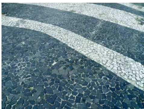
Figura 89: vista do revestimento da Praça dos Imigrantes
