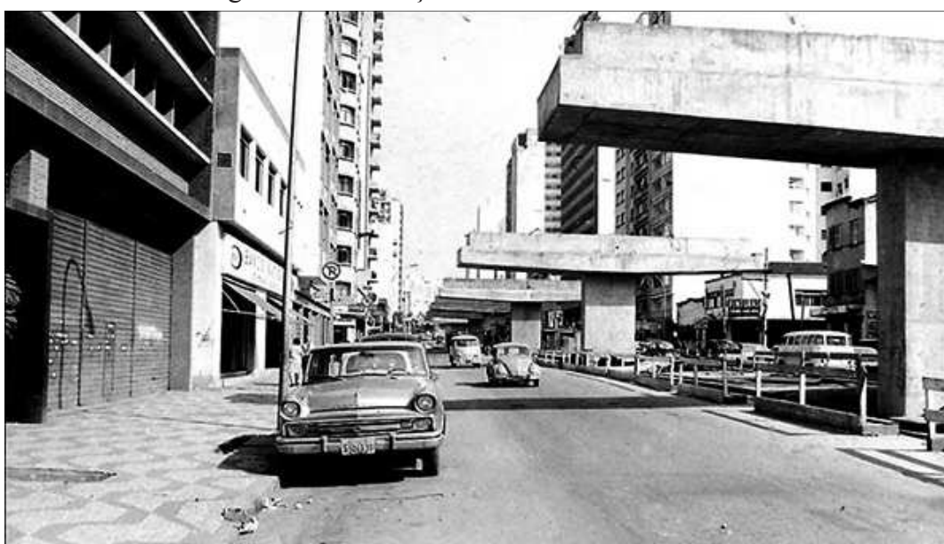
Figura 47: construção do Elevado Costa e Silva
