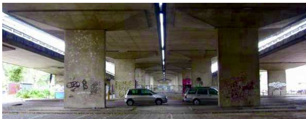
Figura 56: vista do viaduto em 2004
