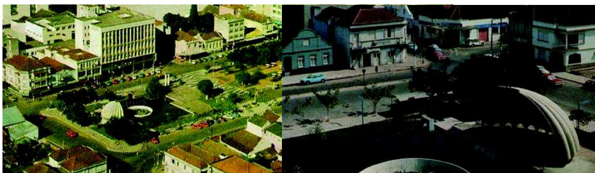
Figura 94: década de 70 – chafariz de águas dançantes e concha acústica da Praça dos Imigrantes
