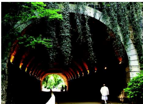
Figura 40: vista do túnel
