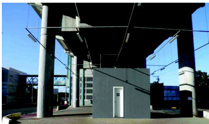
Figura 25: posto policial e sanitário externo da Estação Fenac
