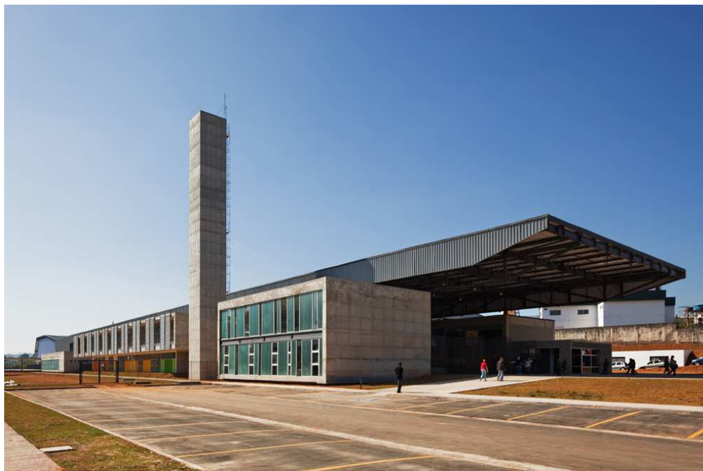
Figura 3 - Escola Céu Pimentas (vista lateral)
