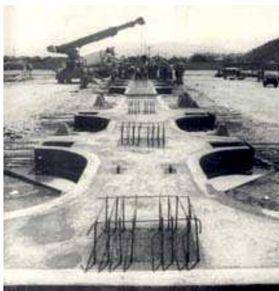
Figura 2 - Estrutura pré-moldada em fabricação
