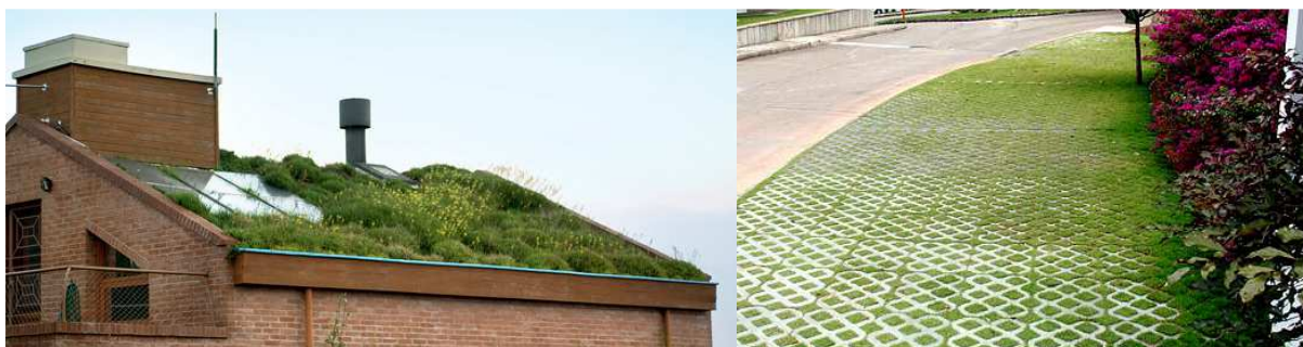
Figura 73 – Cobertura verde e placas fotovoltaicas no telhado de uma residência; piso permeável utilizado na calçada pública. Disponível em: http://www.ecoeficientes.com.br/ . Acesso em 05 de janeiro de 2017.
