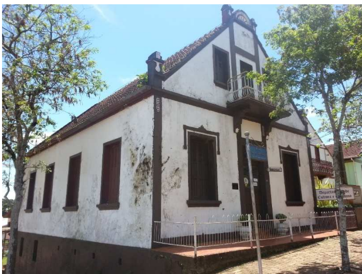
Figura 48 – Casa Benedicto Haunss, imóvel tombado pela Prefeitura Municipal no ano de 2011, atual Biblioteca Municipal de Selbach/RS. Fonte: Fotografia pessoal.
