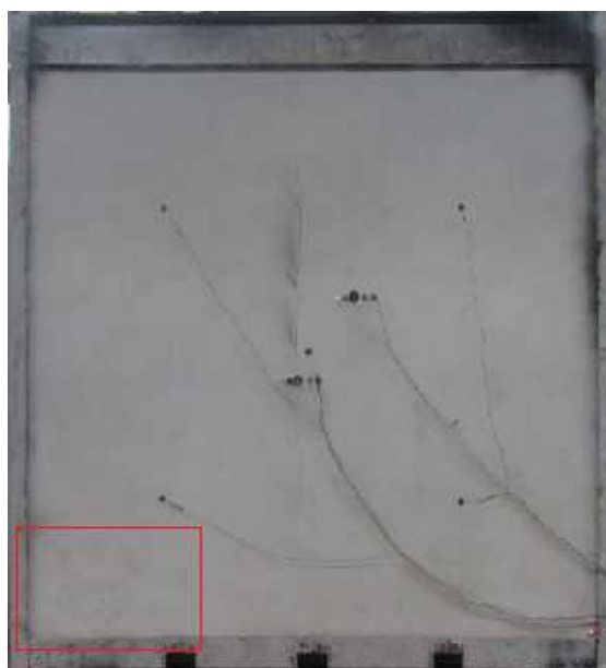
Figura 33 - Fissura lateral esquerda inferior
