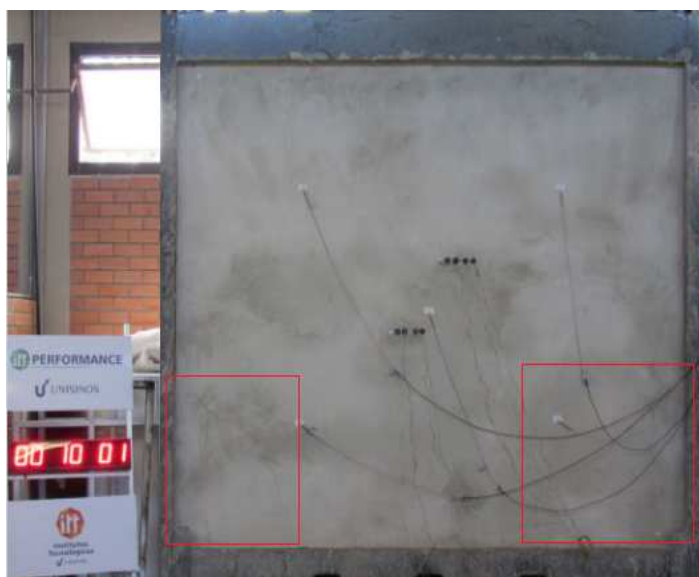
Figura 69 - Surgimento de fissuras oblíquas
