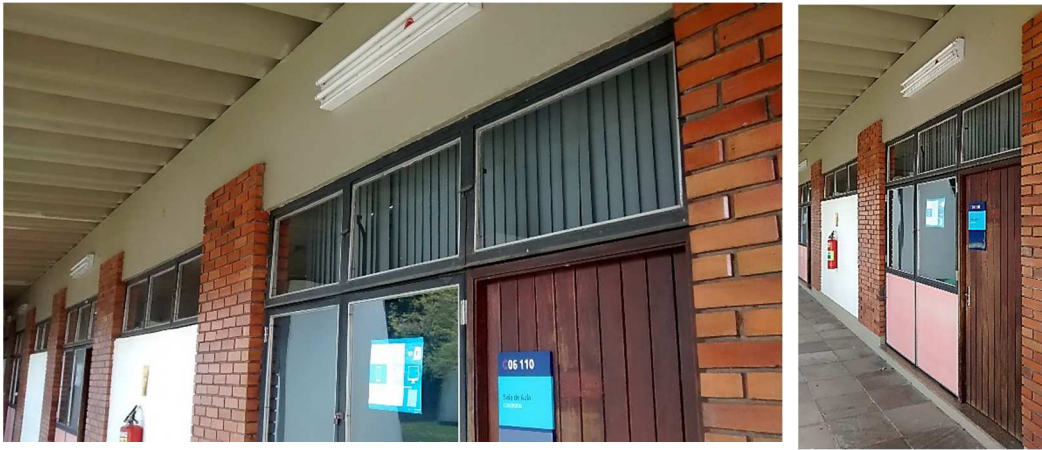
Figura 3.5 - Parede norte e corredor da edificação típica
