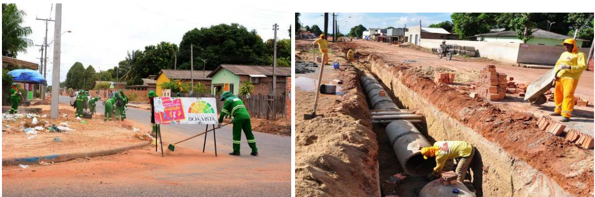
Figura 17 - Serviços de limpeza e de drenagem no bairro Santa Luzia
