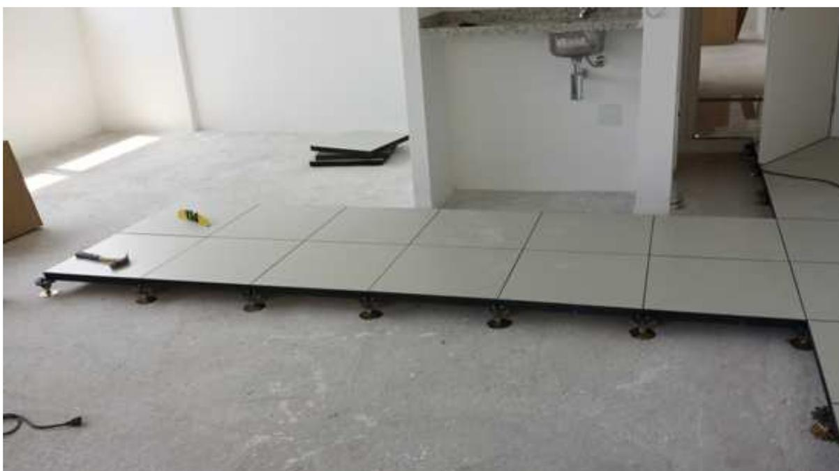
Figura 122 – Instalação de piso elevado. Disponível em: <http://www.ferpisoelevados.com.br>
