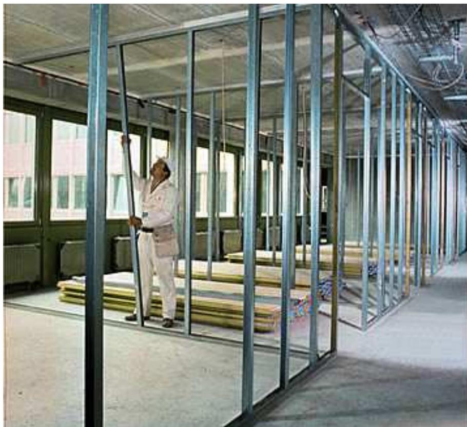
Figura 82 – Estrutura do sistema de divisória leve em gesso acartonado. Disponível em: <http://dicasdaarquitectura.com.br> Acesso: 02 mar. 2016.
