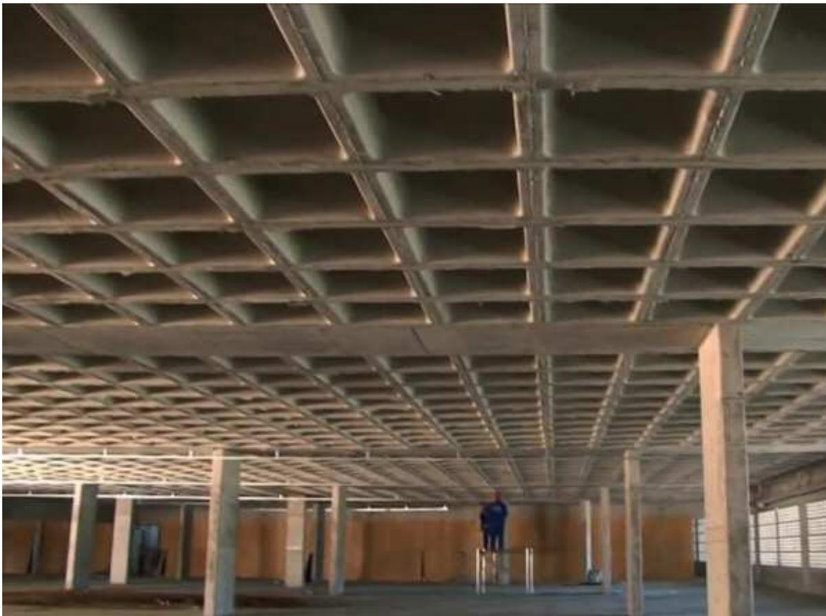
Figura 50 – Laje nervurada. Disponível em: <http://www.ecivilnet.com> Acesso: 28 fev. 2016.
