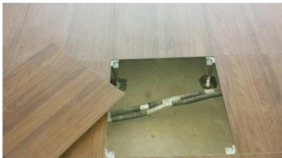
Figura 121 – Remoção de uma placa do piso para acesso às instalações. Disponível em: <http://www.ferpisoselevados.com.br> Acesso: 05 mar. 2016.
