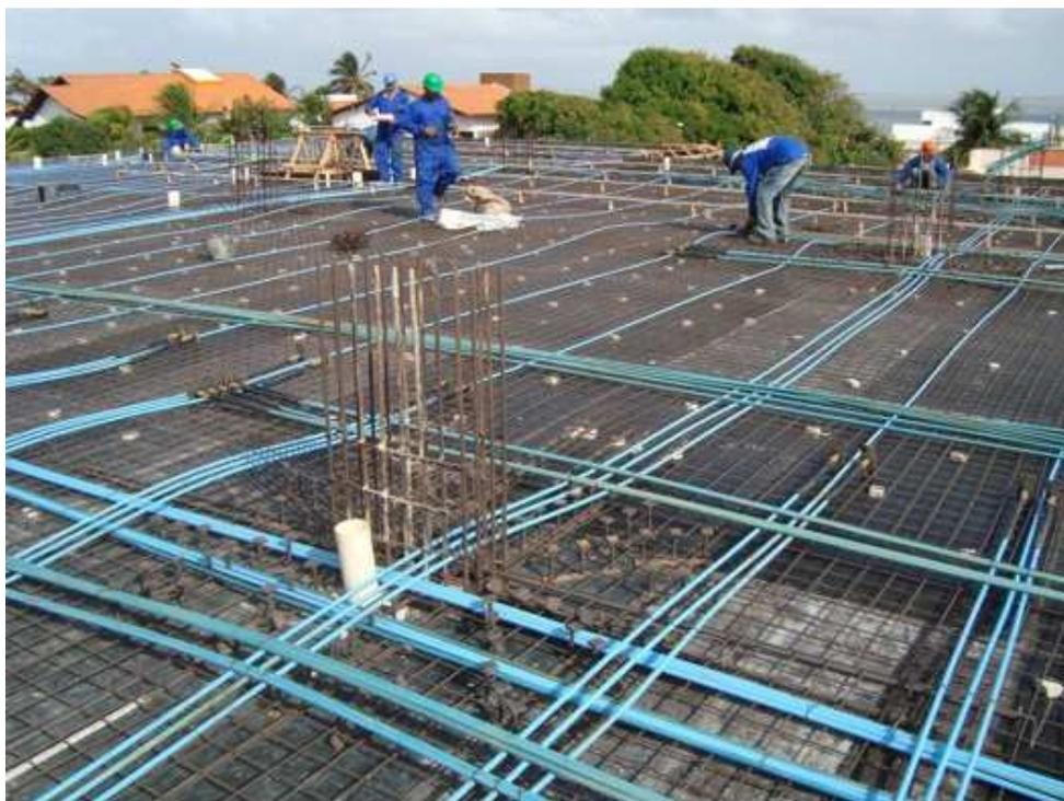
Figura 54 – Cabeamento de laje prontendida. Disponível em: <http://www.gaussprotensao.com.br> Acesso: 28 fev. 2016.
