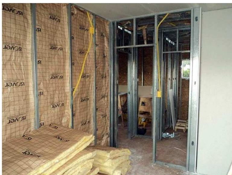
Figura 85 – Instalação de isolamento térmico e acústico dentro de sistema de gesso acartonado. Disponível em: <http://projetos.habitissimo.com.br> Acesso: 02 mar. 2016.
