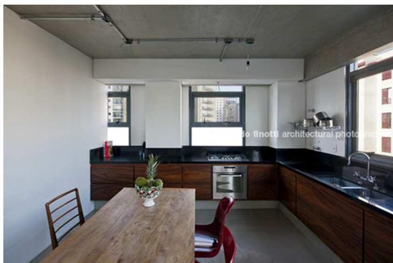
Figura 159 – Edifício Fidalga 772. Imagem interna de um apartamento com tubulações elétricas aparentes sob a laje superior. Disponível em: <http://www.leonardofinotti.com> Acesso: 06 dez. 2016.
