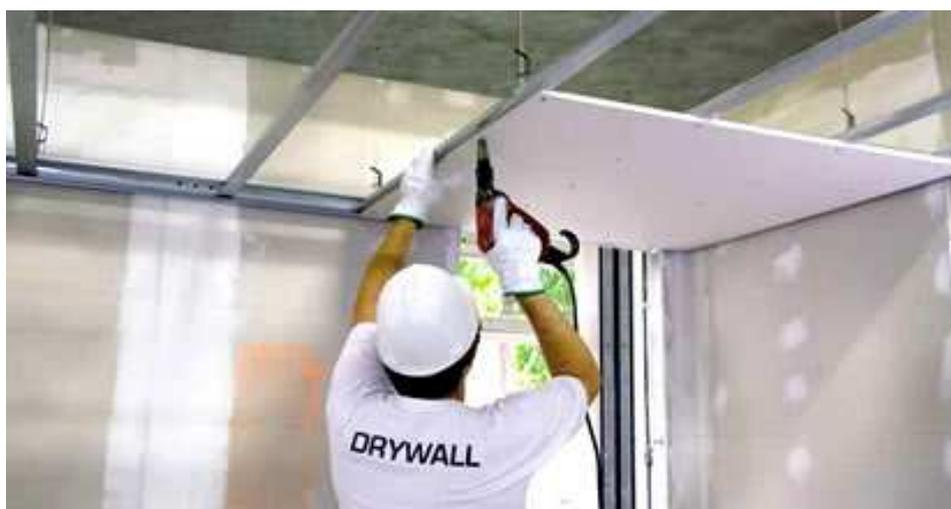
Figura 118 – Execução do gesso acartonado fixado em estrutura metálica. Disponível em: <http://www.divisoriaemcuritiba.ind.br> Acesso: 17 fev. 2016.
