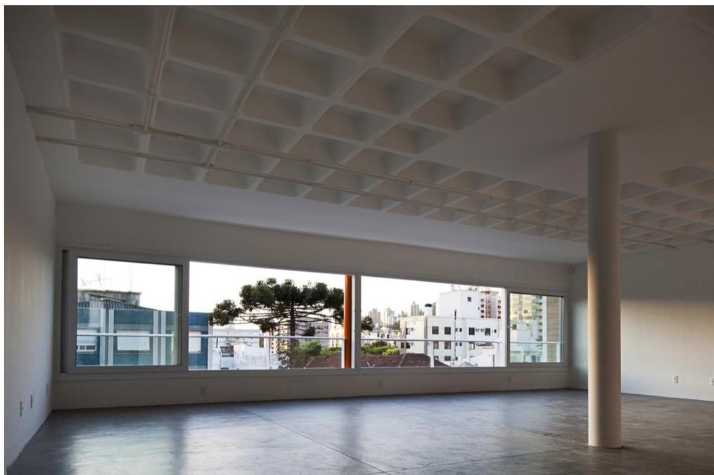
Figura 198 – Edifício Amélia Teles. Imagem interna com laje nervurada aparente. Disponível em: <http://www.archdaily.com.br> Acesso: 28 nov. 2016.
