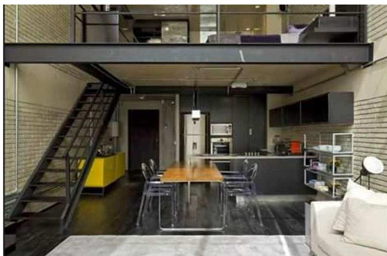
Figura 57 – Mezanino de um loft que utiliza laje em estrutura metálica. Disponível em: <http://www.habitissimo.com.br> Acesso: 28 fev. 2016.
