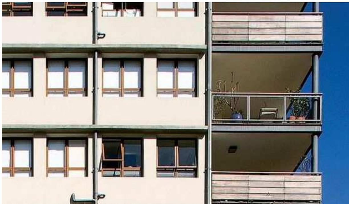
Figura 140 – Edifício 4x4. Tubulações sanitárias externas aparentes. Disponível em: <http://www.arrobacasa.com.br> Acesso: 05 maio 2017.
