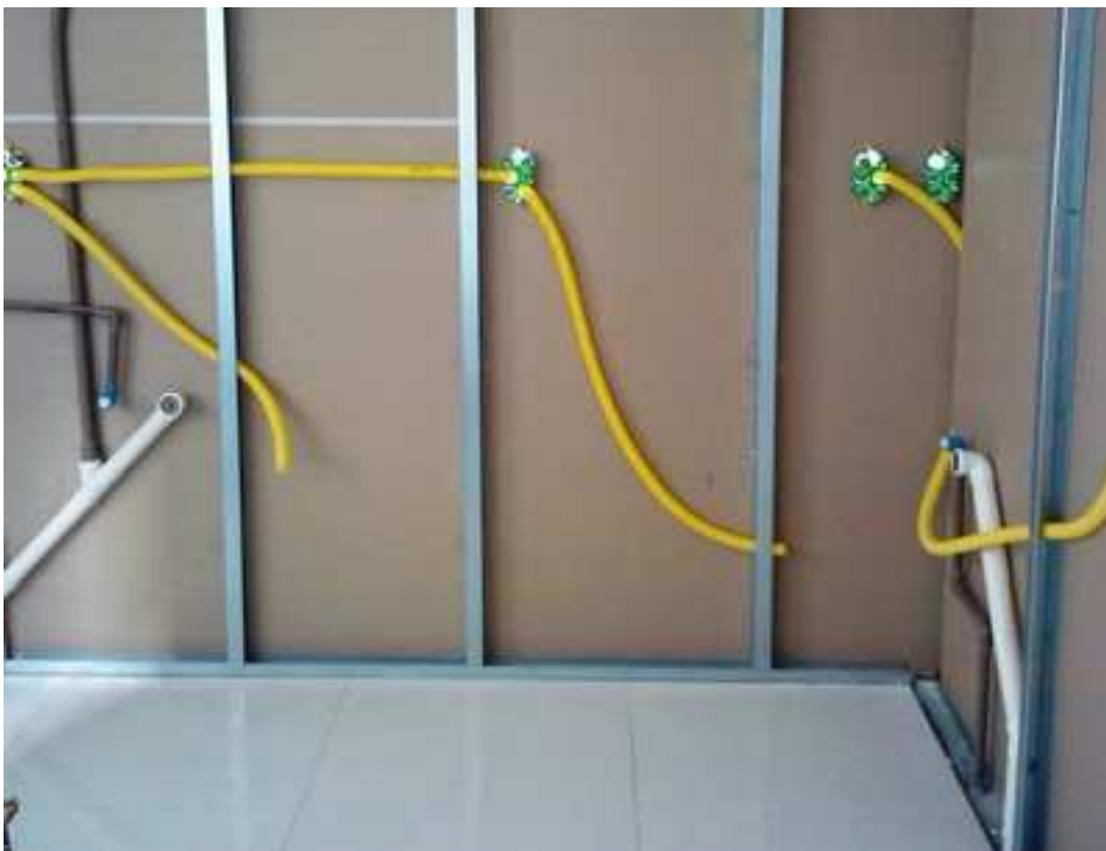
Figura 84 – Execução das instalações dentro do sistema de gesso acartonado. Disponível em: <http://projetos.habitissimo.com.br> Acesso: 02 mar. 2016.
