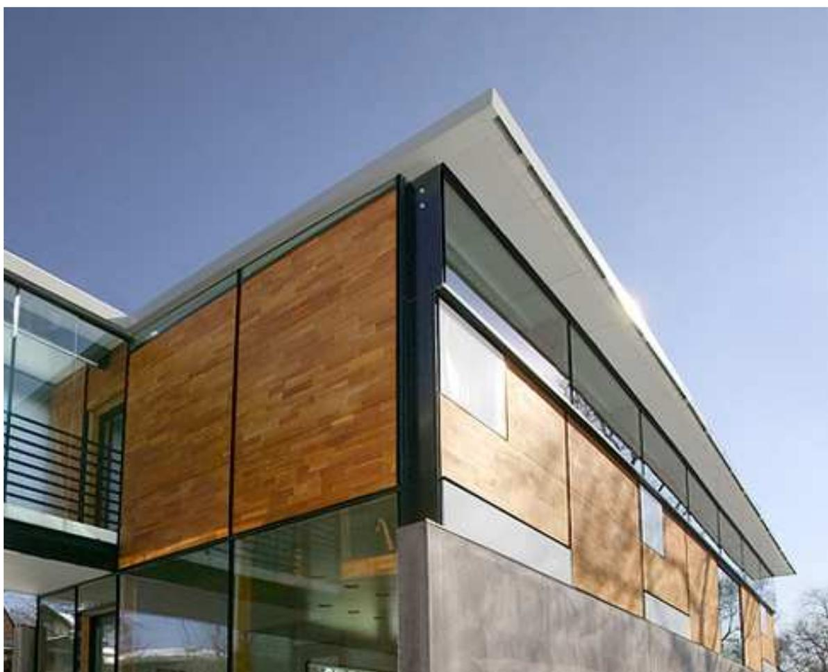
Figura 98 – Sistemas de painéis para fachada da FlatPak House, projetada por Charles Lazor. Disponível em: <http://mocoloco.com> Acesso: 03 mar. 2016.
