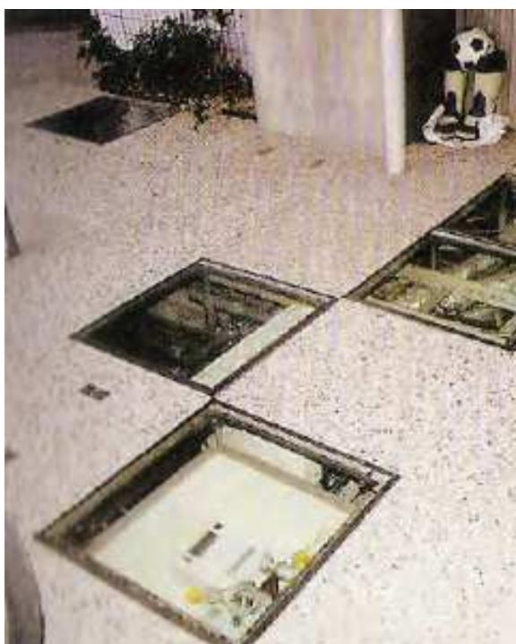
Figura 125 – Piso elevado do Edifício NEXT-21, projetado por Yositika Utida, Osaka, Japão. Fonte: Finkelstein (2009).
