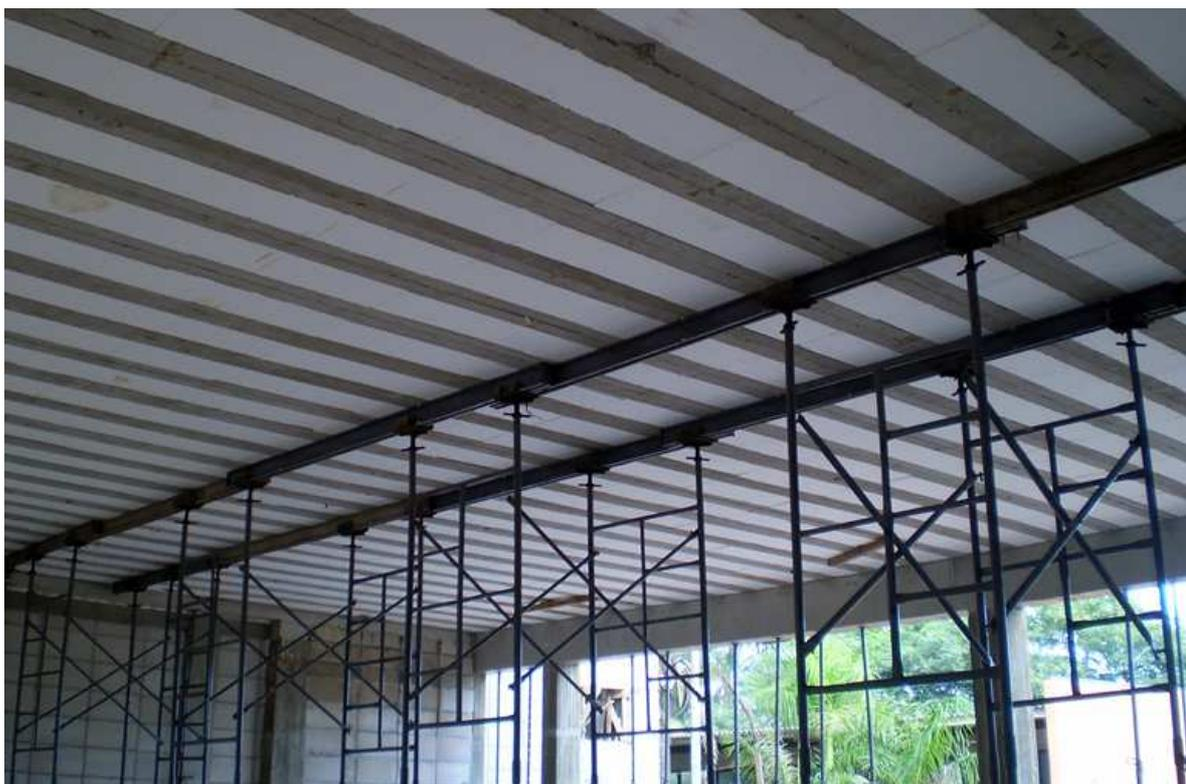
Figura 52 – Laje protendida. Disponível em: <http://www.lajesprotendidas.com.br> Acesso: 28 fev. 2016.
