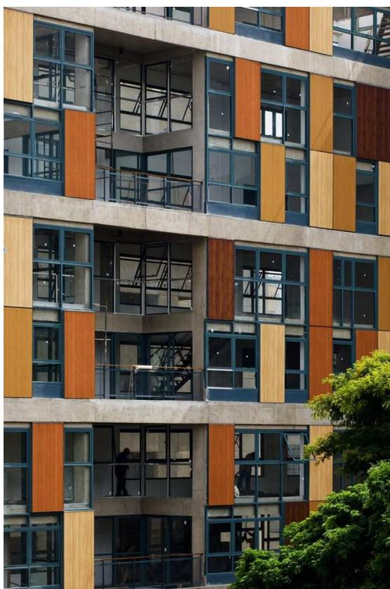
Figura 157 – Edifício Fidalga 772. Fachada livre com painéis opacos e caixilhos de alumínio e vidro . Disponível em: <http://www.arquiteturaguimattos.com.br> Acesso: 08 nov. 2016.
