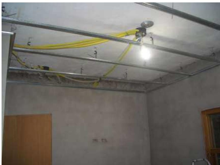
Figura 117 – Instalações elétricas executadas em cima do forro. Disponível em: <http://www.guiadomarceneiro.com> Acesso: 17 fev. 2016.
