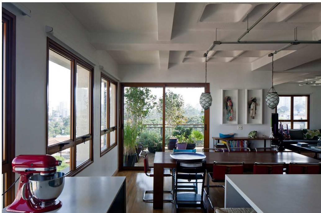
Figura 142 – Edifício 4x4. Imagem interna de um apartamento com tubulações elétricas aparentes sob a laje superior. Disponível em: <http://www.ideazarvos.com.br> Acesso: 08 nov. 2016.
