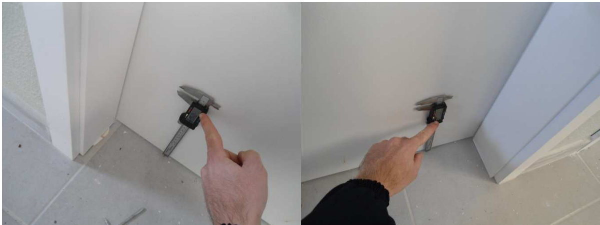
Figura 22 – Medidas das frestas das portas, uma em cada lado da porta
