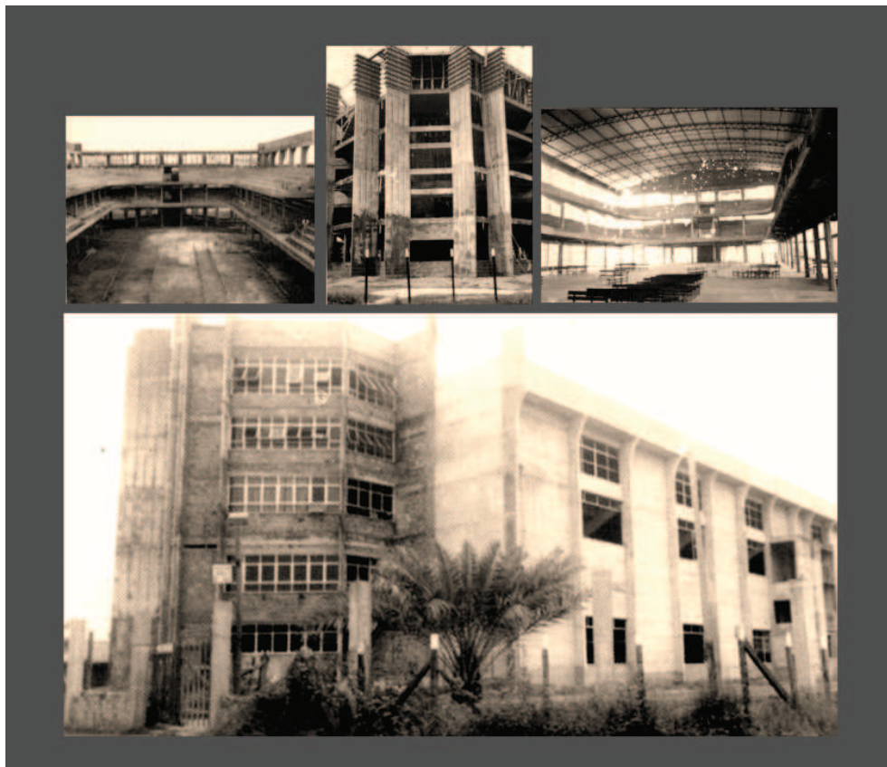
Figura 23 - Templo Central das ADs em Imperatriz-MA em construção.
