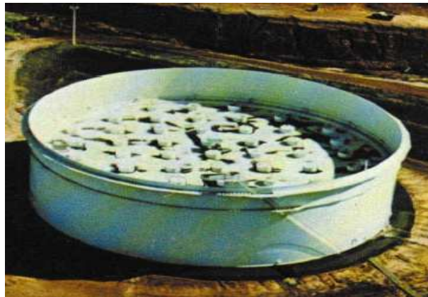
Figura 2.3 – Tanque de teto flutuante Fonte: Adaptado de Barros (1998).
