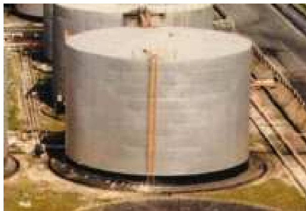
Figura 2.2 – Tanque de teto fixo Fonte: Adaptado de Barros (1998).
