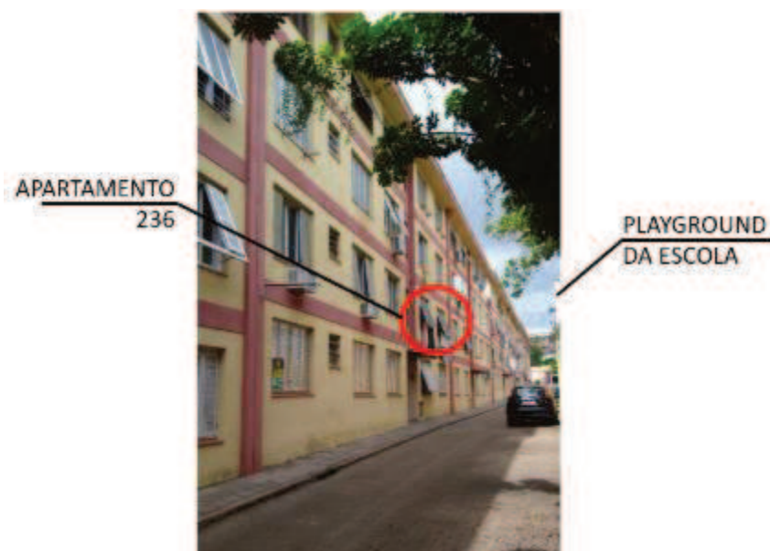
Figura 37 – Foto com a localização do imóvel onde foram realizadas as medições internas
