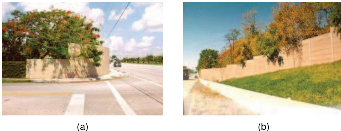
Figura 11 – Modelos de barreira acústica feita por muro de tijolos (a) e combinação de muro e talude em (b)
