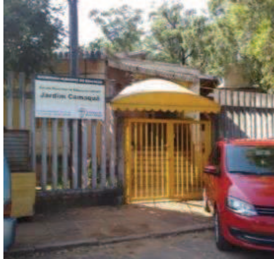
Figura 21 – Vista do acesso da EMEI Jardim Camaquã
