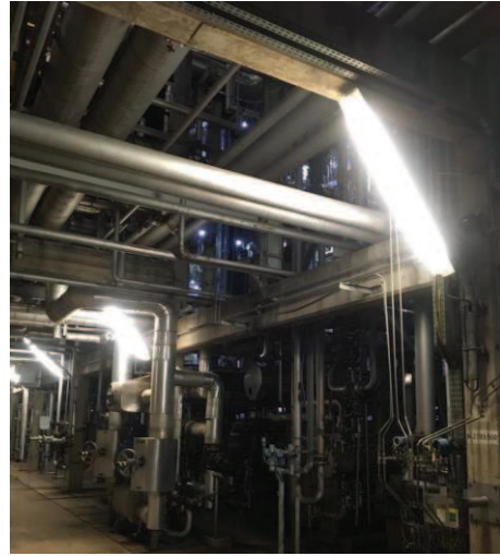
Foto 2 – substituição das luzes queimadas, por luminárias de LED.
