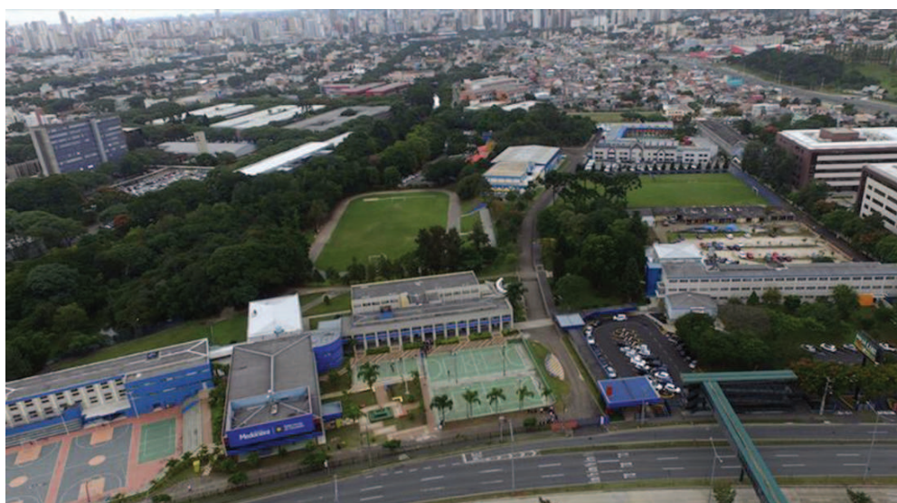
Figura 1 – Vista aérea do Colégio Medianeira
