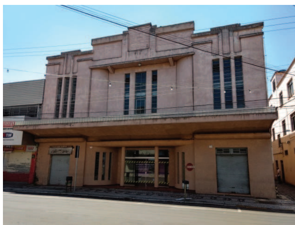
Figura 38 – Imagem do estado atual da fachada do Cine Teatro Luz.
