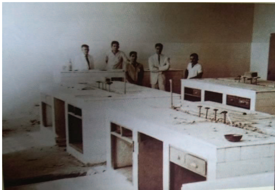
Fotografia 19 - Construção do Laboratório de Química da EAA, 1963
