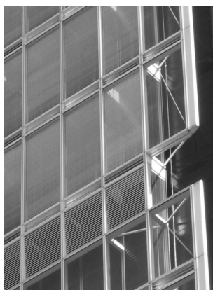
Figura 14 - Fachada Dupla Arag Tower – Dusseldorf - Alemanha
