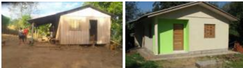
Figura 10 - a) Casa precária a ser substituída por novas no programa habitacional; b) Finalização da construção da casa de Pedro Caetano
