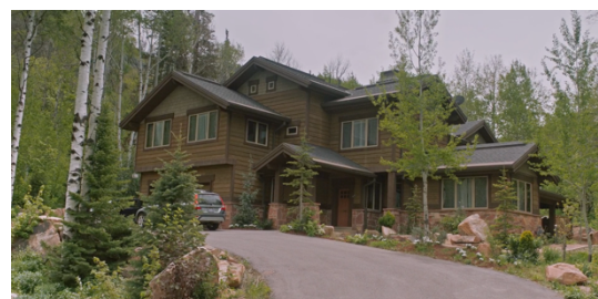
Figura 64 - Casa dos Graham
