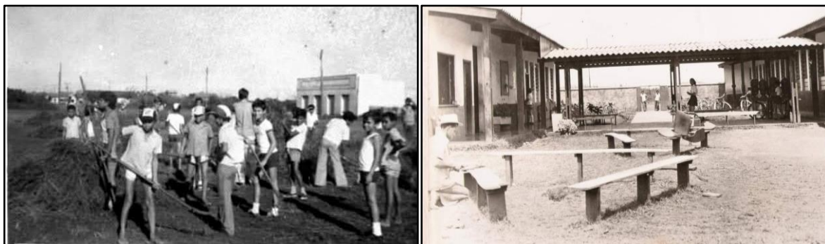
Fotografia 5 - Limpeza do terreno e construção da Escola 29
