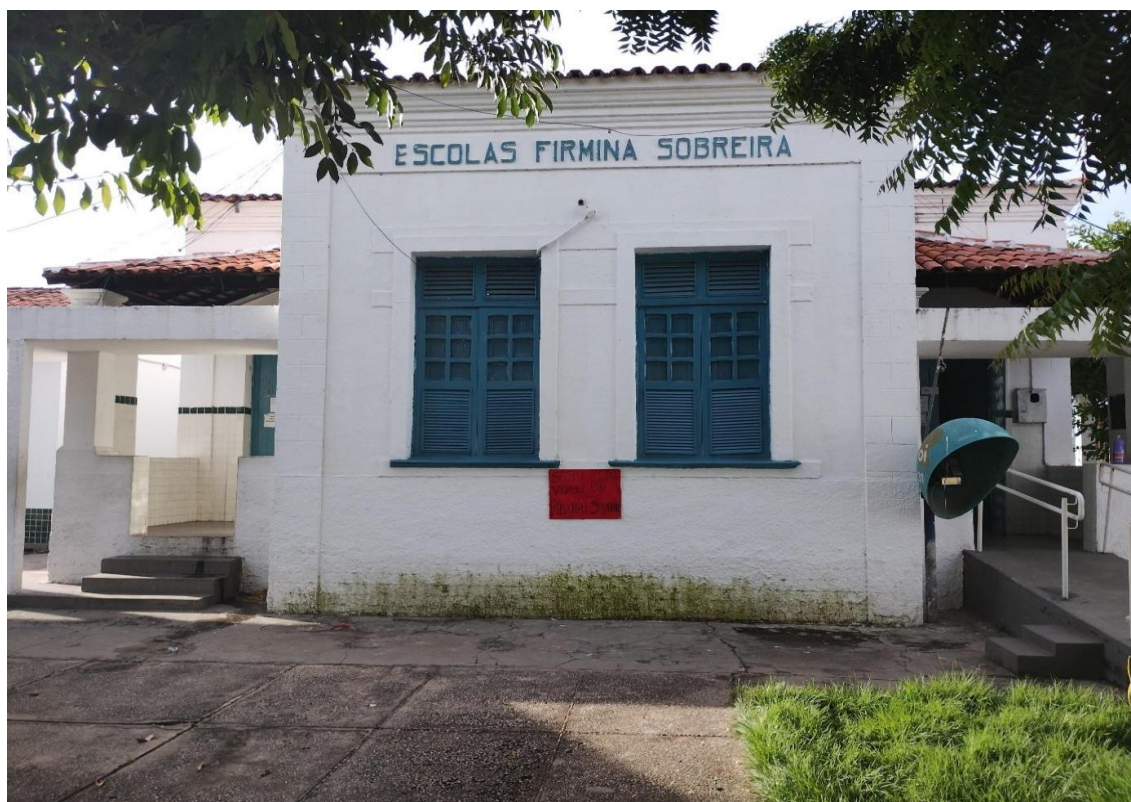
Fotografia 3 – Fachada interna da Unidade Escolar Firmina Sobreira
