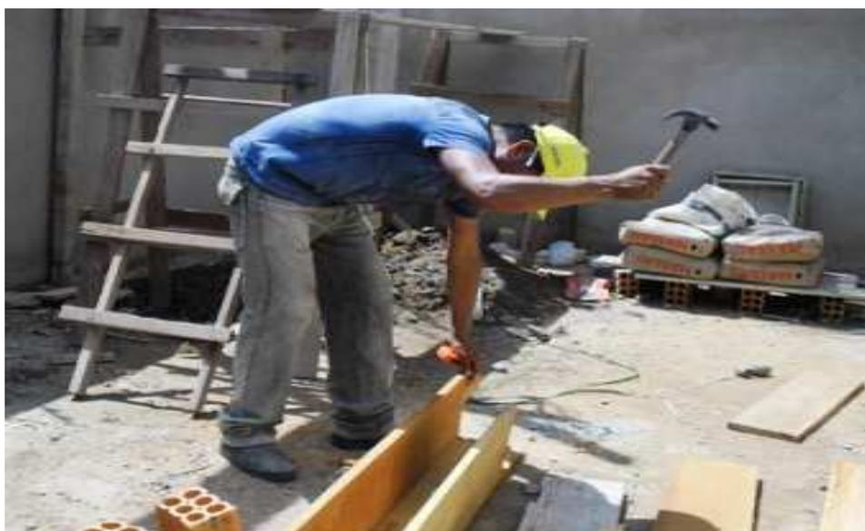
Joel e Rodrigo na elaboração das caixarias para enchimento de concreto. Construção de vigas
