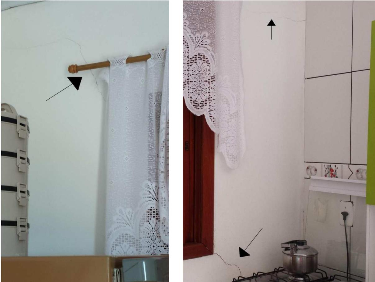
Figura 15 – Trincas na mesma janela indicando a direção do recalque, que fica ao lado esquerdo da janela da cozinha (Fonte: Arquivo Pessoal, 2015).
