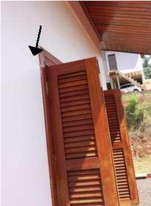
Figura 10 – Fissura diagonal na parede no canto superior da abertura, a espessura é pequena, mas indica rompimento devido à tração e se “deita” para o ponto de maior recalque (Fonte: Arquivo Pessoal, 2015).
