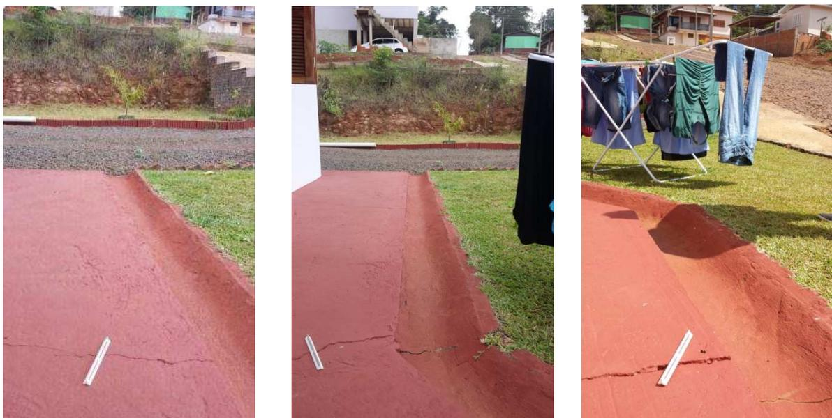
Figura 8 – Imagens de três fissuras transversais na calçada na fachada frontal, indicando maior recalque em direção ao ponto em que o aterro apresenta maior espessura (Fonte: Arquivo Pessoal, 2015).
