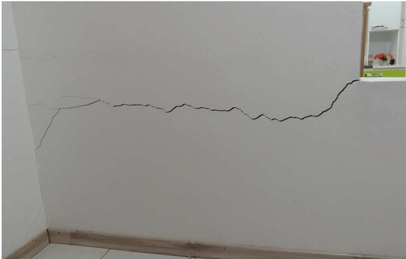
Figura 13 – Aproximação da fissura da Figura 11. Rachadura horizontal rompida por tensões de tração sobre ponto de maior recalque, na divisa da cozinha com a sala (Fonte: Arquivo Pessoal, 2015).
