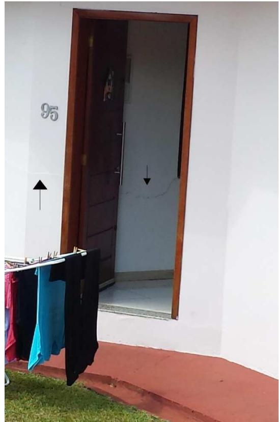
Figura 11 – Fissuras horizontais em cima do ponto de maior recalque (Fonte: Arquivo Pessoal, 2015).
