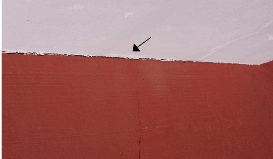
Figura 9 – Fissura longitudinal na calçada da fachada frontal, indicando redução de volume do aterro no ponto localizado (Fonte: Arquivo Pessoal, 2015).
