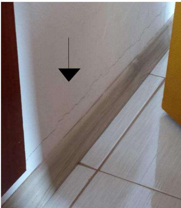
Figura 18 – Fissura horizontal na sala divisa com a suíte (Fonte: Arquivo Pessoal, 2015).
