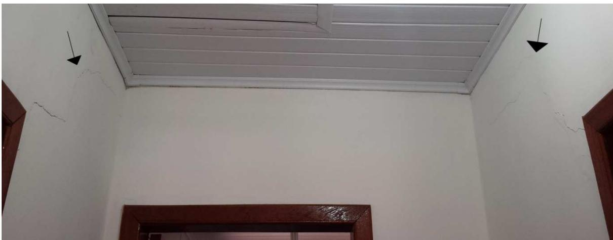
Figura 20 – Fissuras diagonais na entrada dos quartos, elas aparecem dos dois lados da parede (Fonte: Arquivo Pessoal, 2015).
