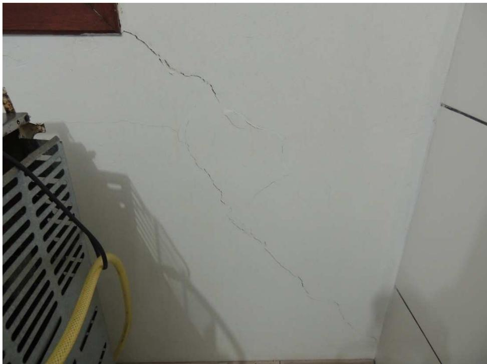
Figura 16 – Aumento da trinca da figura 15, as fissuras tendem a deitar para o lado do recalque (Fonte: Arquivo Pessoal, 2015).
