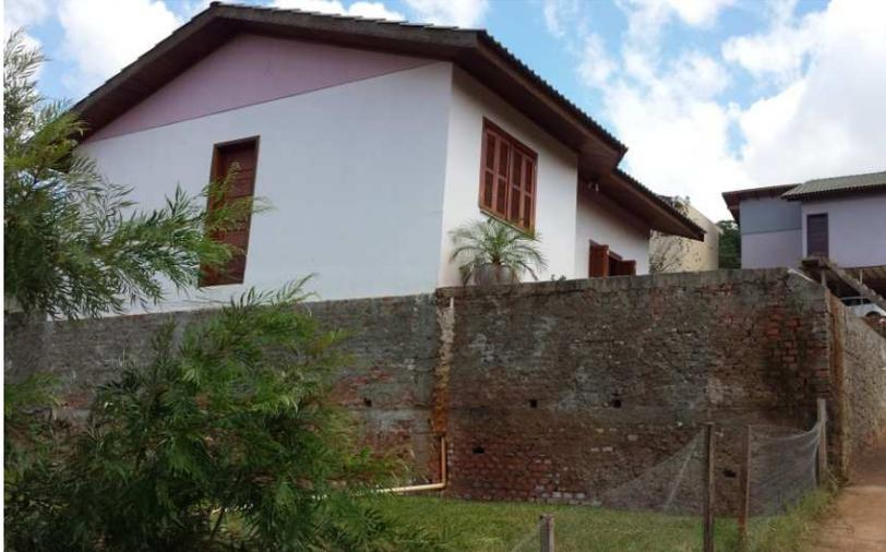
Figura 12 – Vista lateral, muro de arrimo com espessura do aterro (Fonte: Arquivo Pessoal, 2015).
